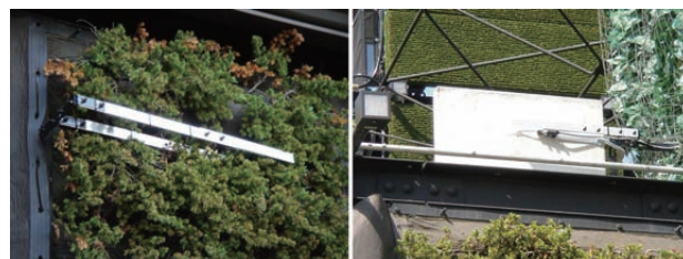
写真-3 自立型緑化壁における温度測定状況（左：緑化壁面 右：非緑化壁面）
