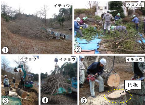
写真1 地上部の伐倒作業
