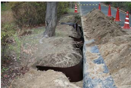
写真5 根系誘導シート
