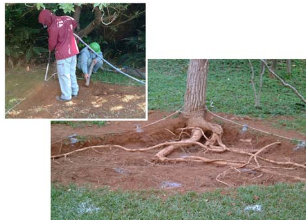
写真1 圧縮空気を利用した土壌掘削
