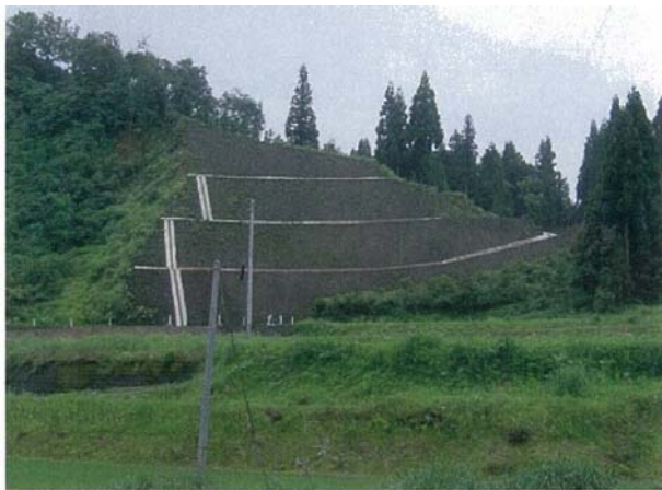
写真3. 表土を利用した事例；新潟県南魚沼市（施工8ヵ月後）
