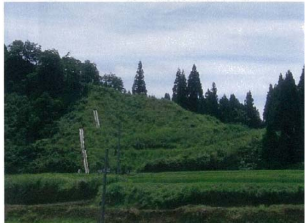
写真4. 表土を利用した事例；新潟県南魚沼市 （施工1年10ヵ月後）
