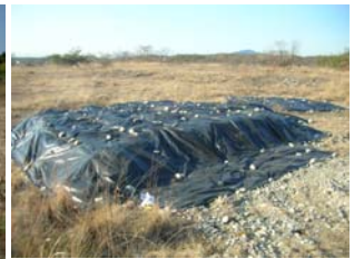
図-8 処分表土への防草シート設置状況
