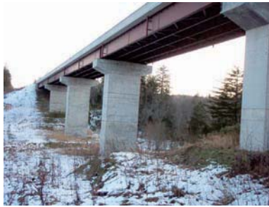
BR: 谷部において橋梁を設置し道路下を移動させるアンダーパス(豊富 BP)
