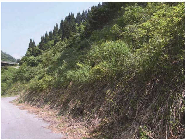
写真-3 滋賀県の調査地（調査地番号 12）
