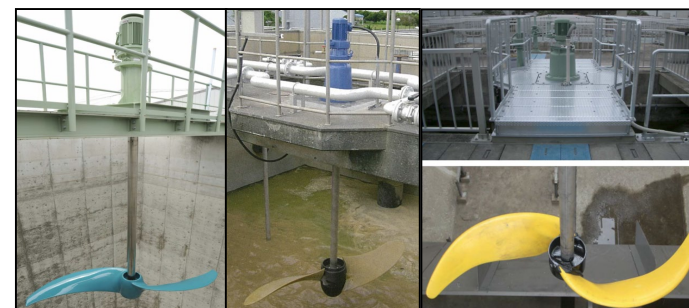
省エネ型反応タンク攪拌機例
