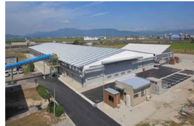
汚泥コンポスト化施設
