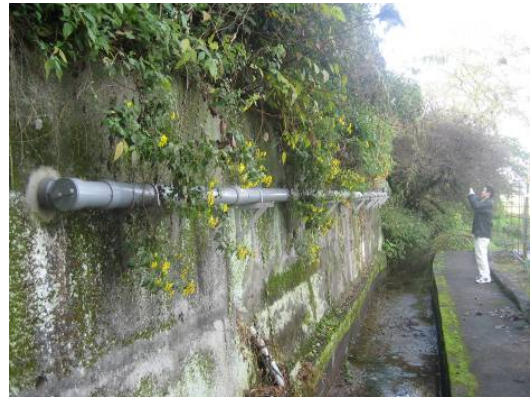
写真-1 クイック配管（露出配管）
