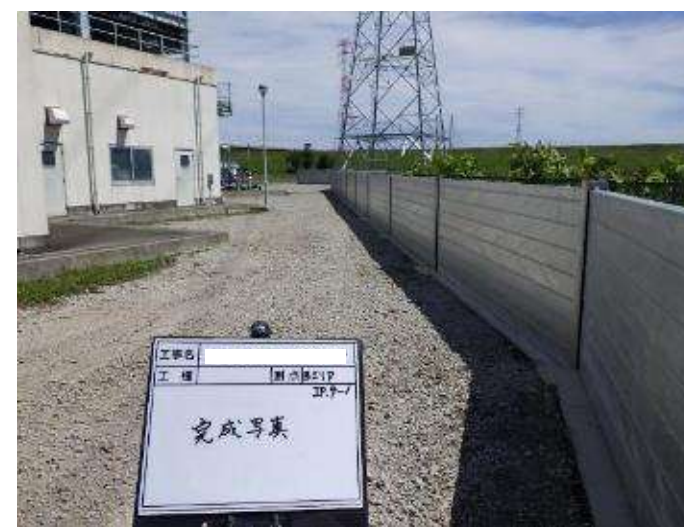
止水壁の設置
