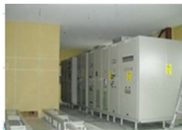
主要設備の上階への移設
