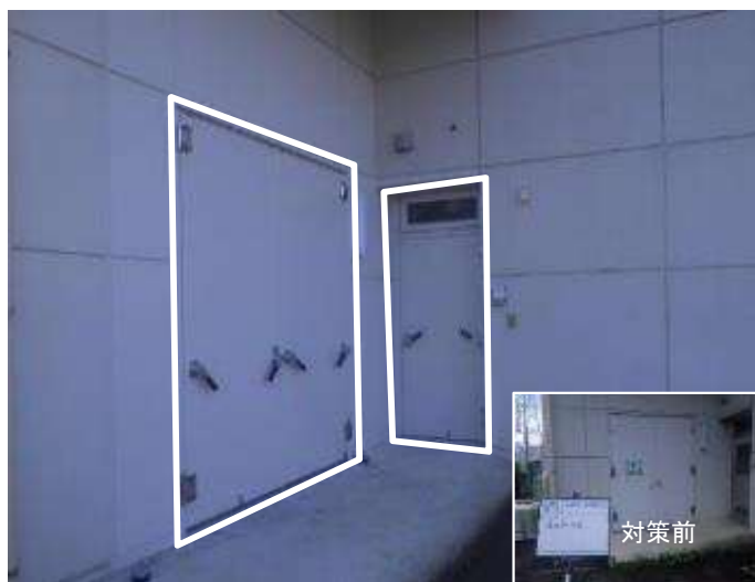
耐水扉の設置
