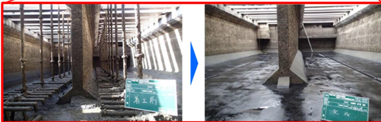
既存施設を調整池等に改造するイメージ (例：施設内の設備撤去状況)
