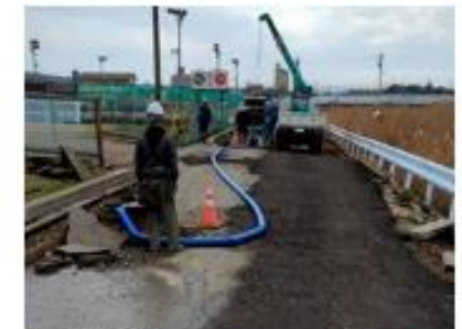
七尾市 バイパス管により下流のマンホールに送水
