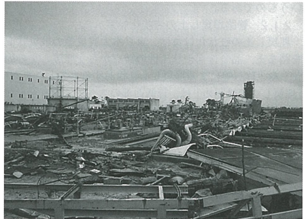
写真1 東日本大震災直後の仙台市南蒲生浄化センター
