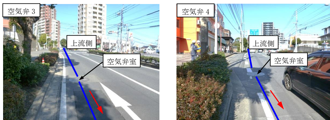
写真 3.5-1 空気弁 3 及び空気弁 4 の周辺の状況
