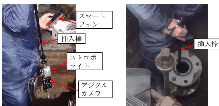
写真 5-10 デジタルカメラ調査状況（空気弁室での調査）
