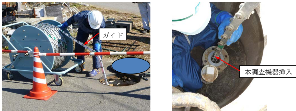
写真 2-4 視覚調査の状況
