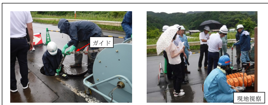
写真 3.6-2 視覚調査の状況
