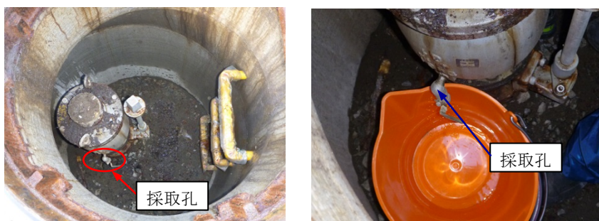
写真 5-1 空気弁の採取孔設置状況の一例
