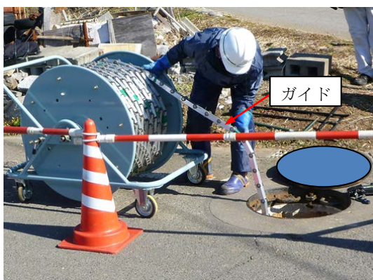
写真 5-8 本調査機器挿入の状況
