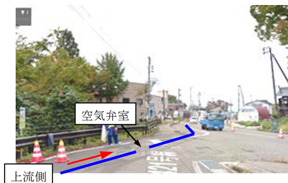
写真 3.1-1 空気弁 1 の周辺の状況
