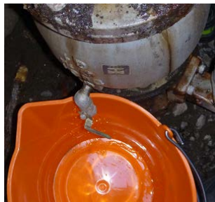
写真 3.3-2 下水排出の確認
