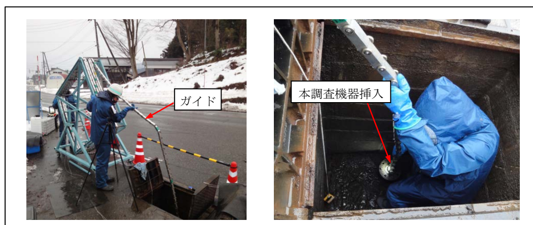
写真 3.1-2 視覚調査の状況
