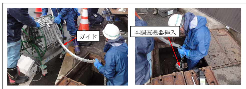
写真 3. 2-2 視覚調査の状況
