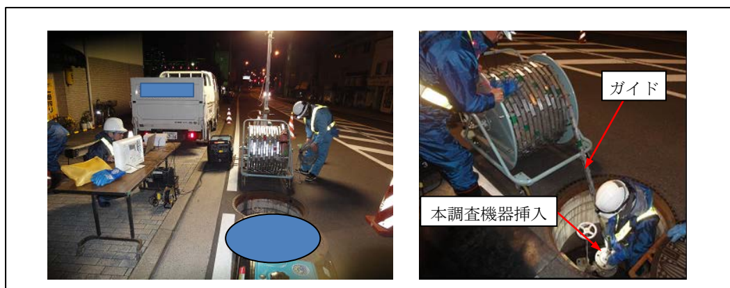
写真 3.4-2 視覚調査の状況
