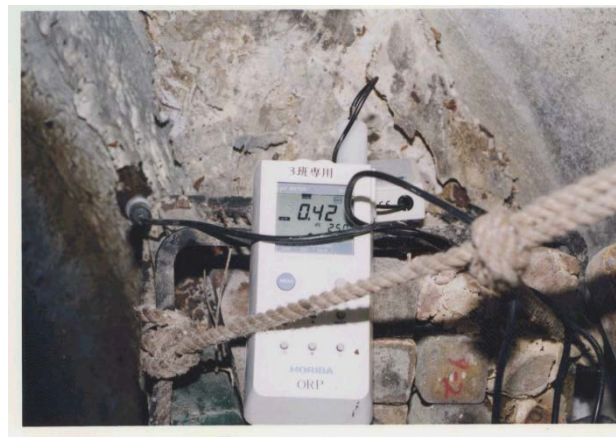
写真 1-2 マンホール内での pH 測定事例
