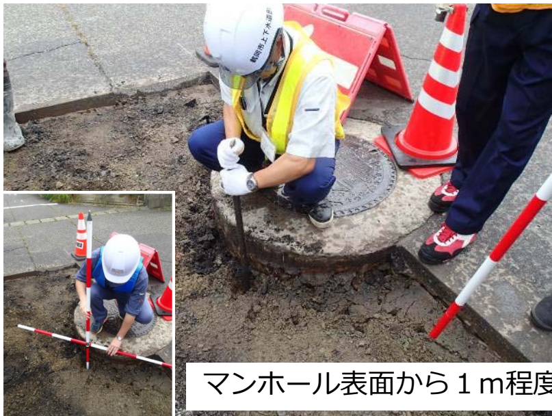
写真－7 溝の深さ確認
