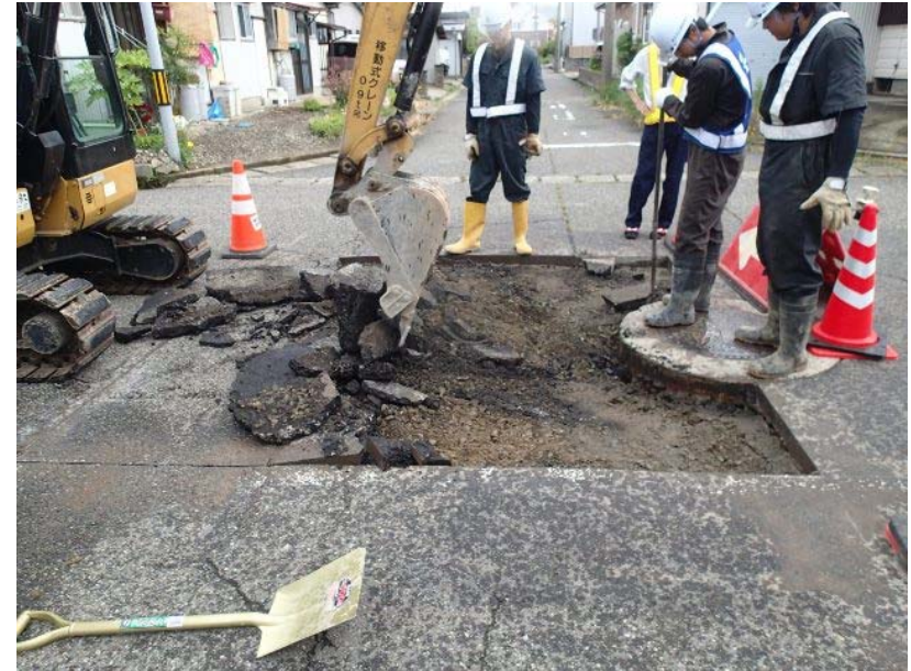
写真－6 陥没マンホールの補修の様子
