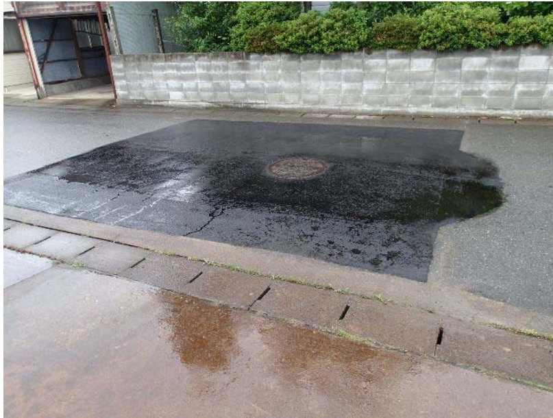
写真 - 9 陥没補修済み
