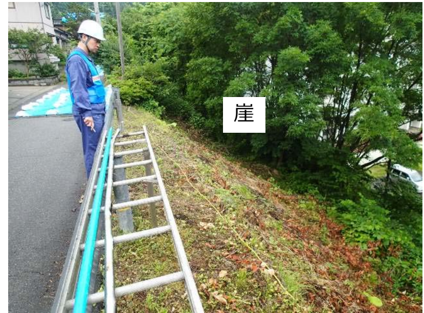
写真-13 崖側の状況
