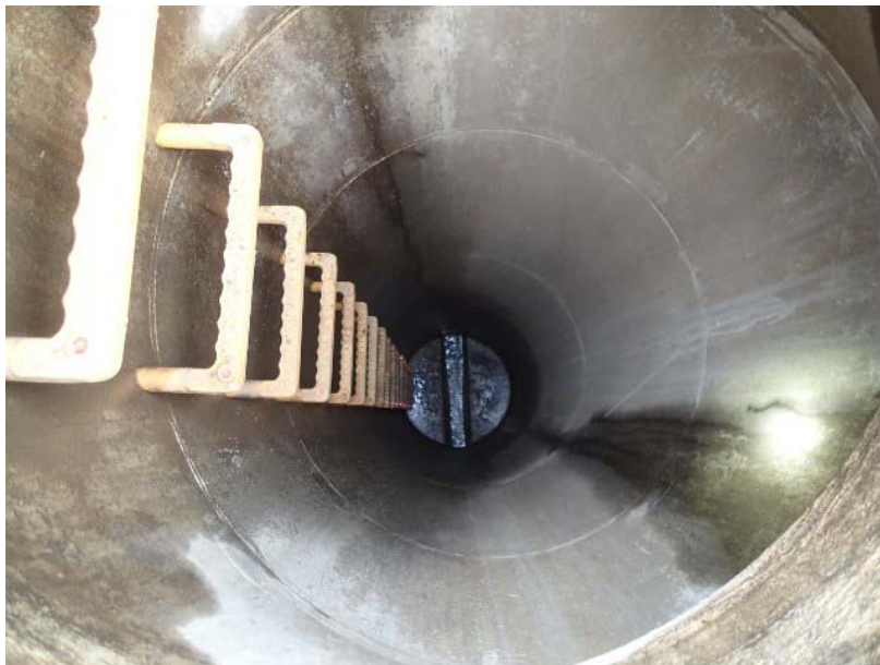
写真-18 マンホール内の状況
