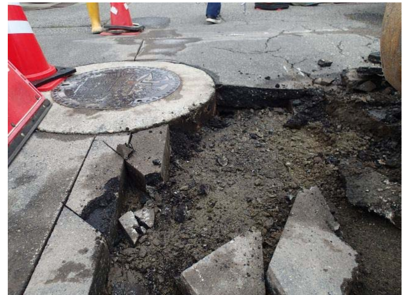
写真-4 陥没マンホールの補修の様子
