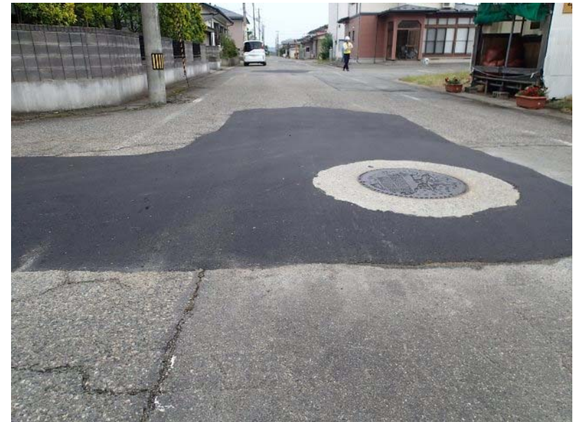
写真-2 陥没補修済みマンホール
