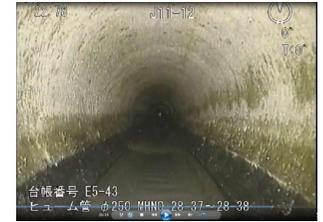
平成4年設置 ヒューム管φ250 (ディスポーザー41戸、圧送距離290m圧送後)
