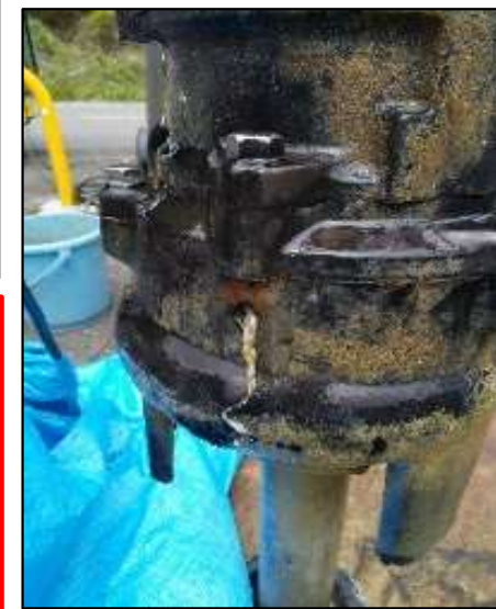
エアロック: 空気孔のし渣詰まり
