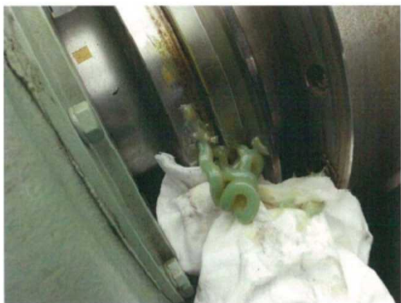
脱水機 主軸受保全状況
