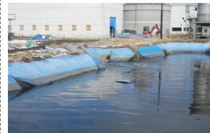
応急復旧の事例（仮設沈殿池・素堀）
