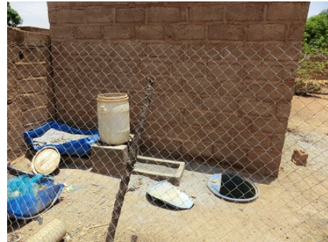
写真-6 シャワー室（壁の向こう側） ・傾斜土槽処理システム（壁の手前）
