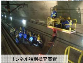
トンネル特別検査実習
