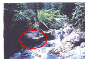
田沢湖線六枚沢橋りょう洗掘(H7.9)
