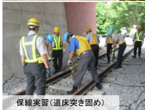
保線実習(道床突き固め)
