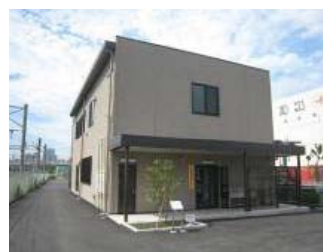
実習棟 (東京支社)
