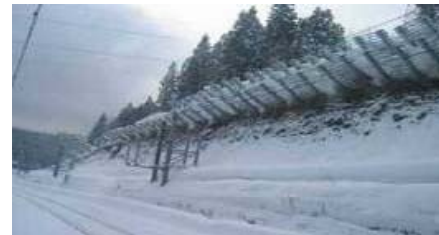
なだれ止柵(奥羽本線)
