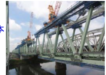
常磐線根川橋りょう架替
