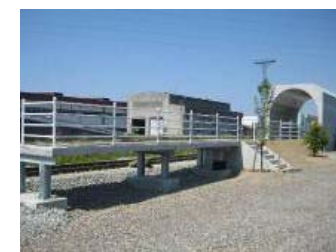
ホーム・トンネル(新潟支社)
