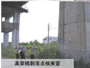
高架橋剥落点検実習
