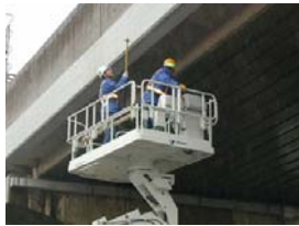
高所作業車を用いた打音検査
