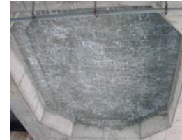
地域に特有の変状例(アルカリ骨材反応)
