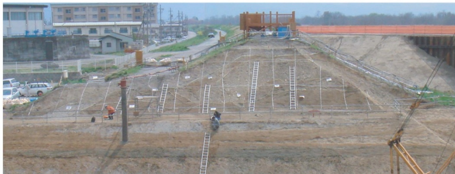
開削断面写真
