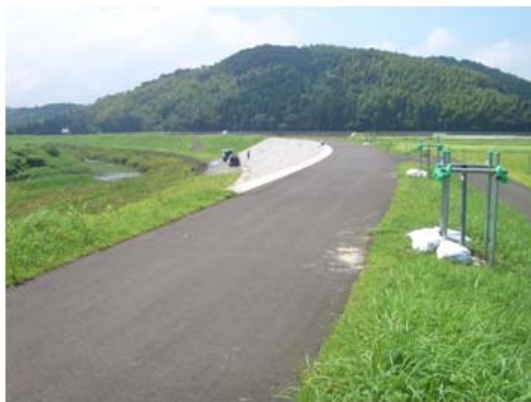
観測孔の設置完了時の状況
