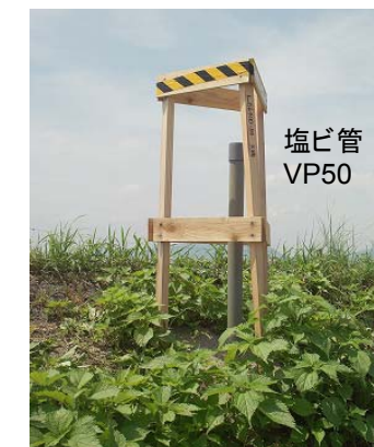
観測孔設置状況
