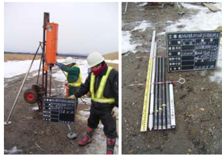
作業状況 観測装置・ロッド一式
