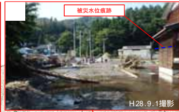
浸水解消後の流木等散乱状況
