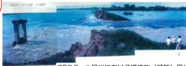
S56.8 小貝川における構造物（樋管）周りの破堤
