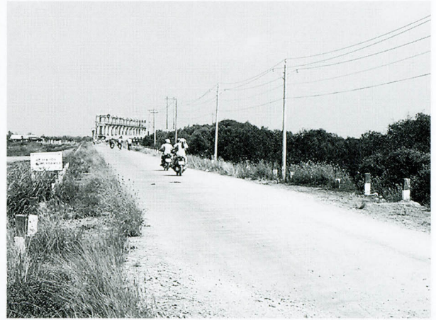
写真-7 右岸側から見たフラップゲート式潮留め堰。遙か彼方に堰の本体が見える。写真を撮影したところは河道の中の突堤の上
