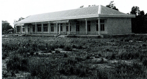
写真-5 タンタイン村のなかに建てられた学校
