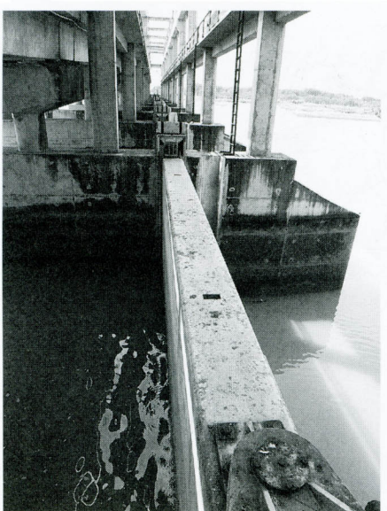
写真-8 フラップゲート。手前側にヒンジが見える。ゲートが閉まった状態となり、下流側（左側）の方が水位が高いことがわかる
