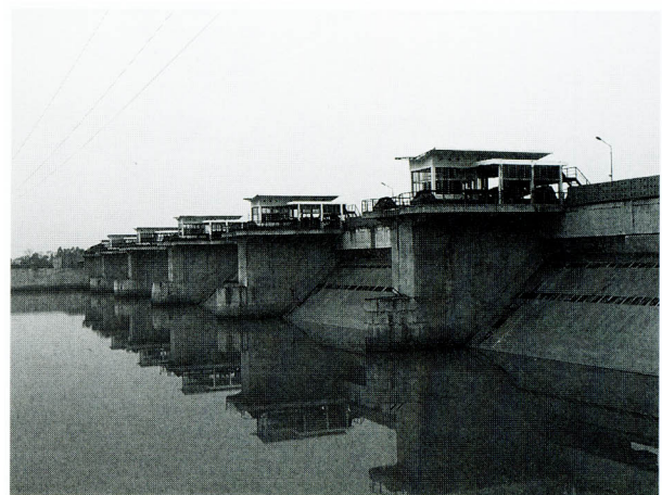
写真-2 下流から見たダイ堰
