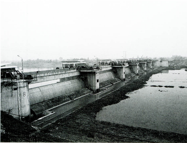
写真-1 上流から見たダイ堰
