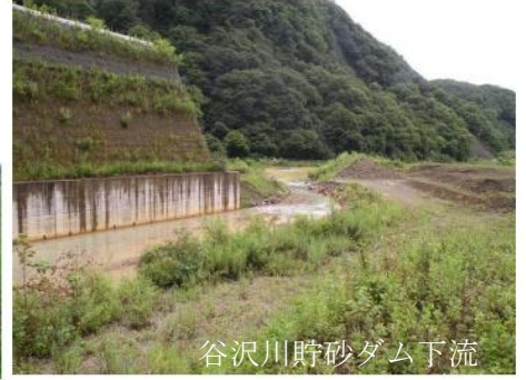
建設発生土受入地 B
