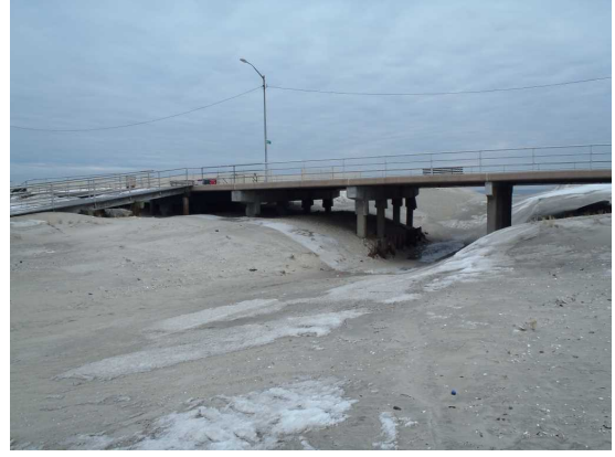
写真-11 ボードウォークの橋脚部
