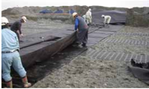
図-2 袋材の敷設
