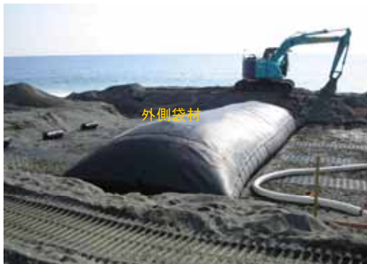
図-6 外側袋材の設置
