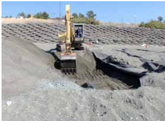
図-13 中詰め材の撤去状況
