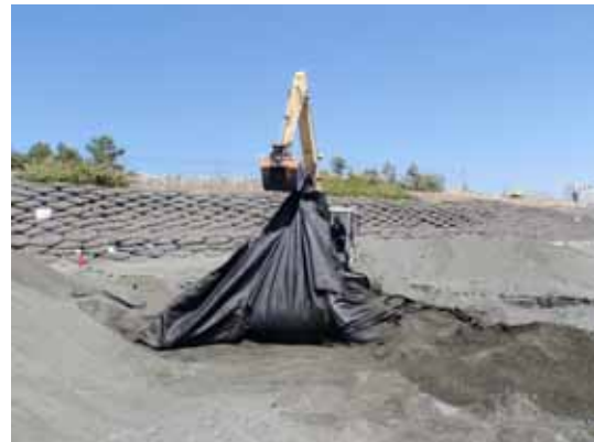
図-14 袋材の撤去状況
