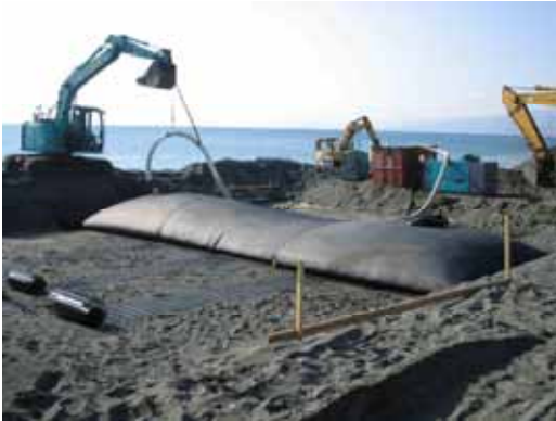
図-4 中詰め材充填工の全景
