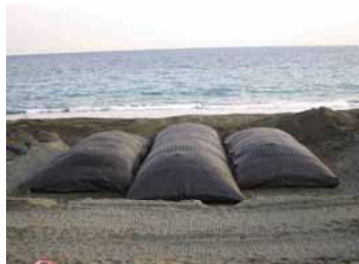
図-7 袋体の設置完了
