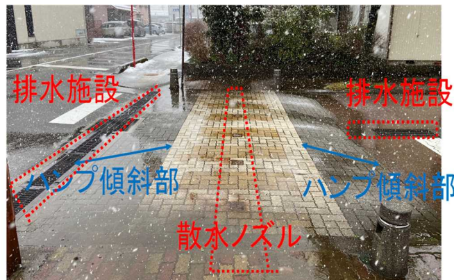
図1 除雪グレーダー及び消雪パイプを設置したハンプ
