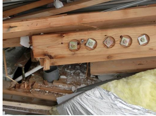
写真 3.3-7 写真 3.3-6 の建物の写真筋かい端部、柱脚接合部
