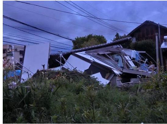
写真 3.3-1 4/15 時点では壁が外れただけの家屋（左）が本震で倒壊（右）した例
