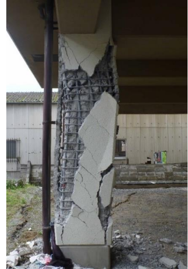
写真 3.5-3 付着割裂破壊した柱
