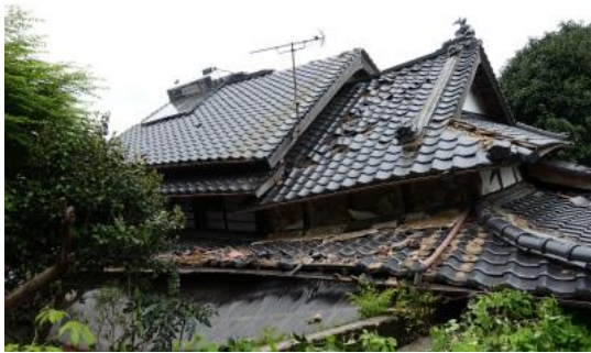
写真 3.3-8 倒壊した木造住宅
