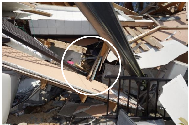
写真 3.6-4 地盤変状が認められ、基礎に損傷が著しい事例 2
