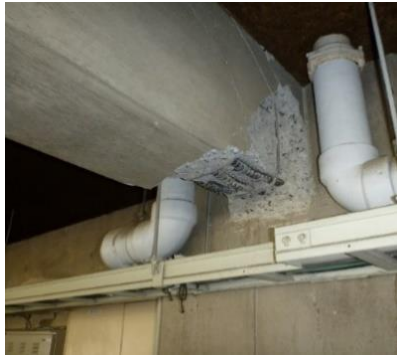
写真 3.5-1 主筋が座屈・破断した柱頭部
