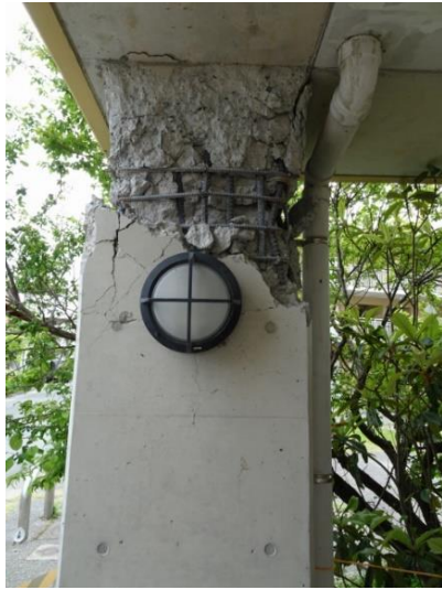
写真 3.5-1 主筋が座屈・破断した柱頭部
