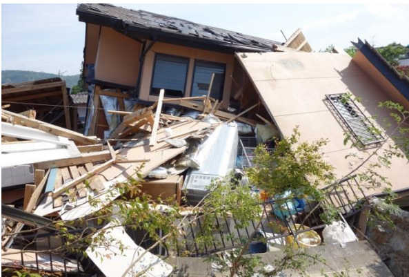
写真 3.6-4 地盤変状が認められ、基礎に損傷が著しい事例 2
