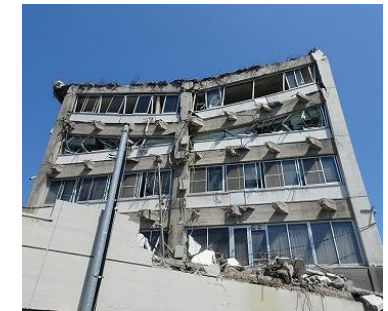
写真 3.5-6 大きく損傷したベランダ側の非構造壁
