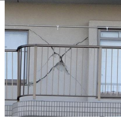
写真 3.5-3 付着割裂破壊した柱
