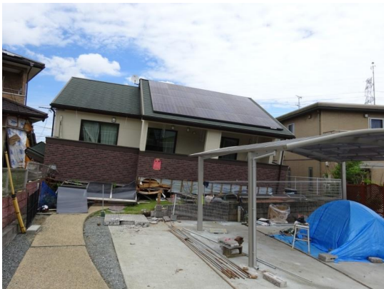
写真 3.3-4 倒壊した木造住宅
