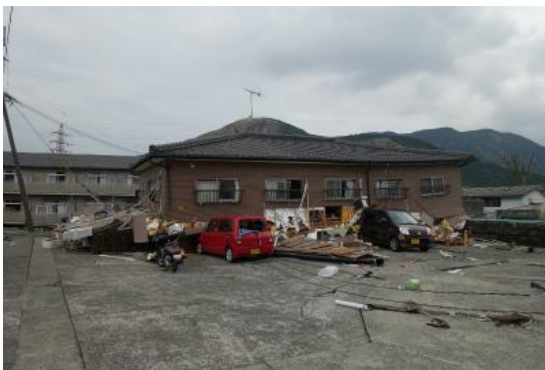
写真 3.3-14 倒壊した木造アパート
