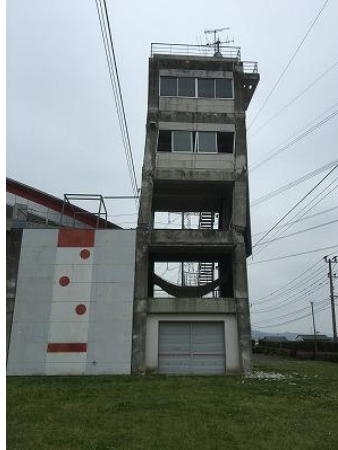
写真 3.5-5 3, 4層の損傷集中による大きな残留変形
