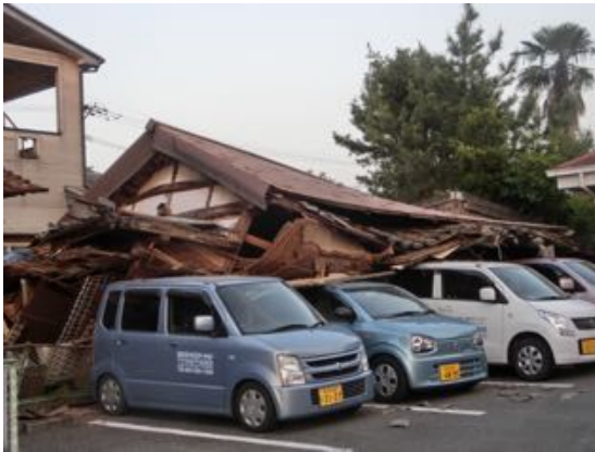
写真 5.5.10 納屋の倒壊
