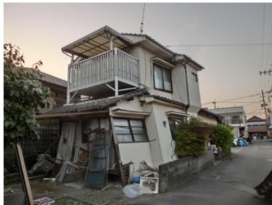
写真 5.5.5 残留変形が大きな家屋
