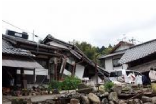
写真 3.18 倒壊した木造住宅
