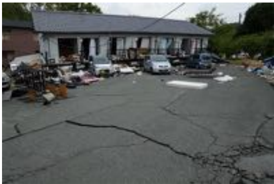
写真 4.19 敷地のひび割れ
