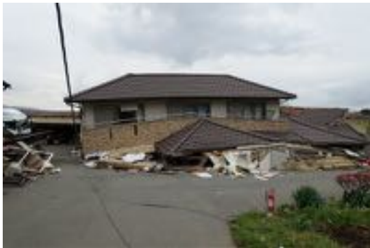
写真 4.16 倒壊した木造住宅（金物あり）
