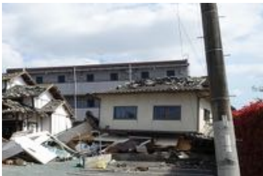
写真 2.17 倒壊した木造住宅
