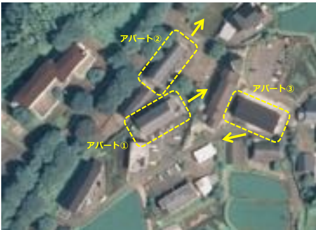
図 4.2 倒壊したアパートの位置（矢印は倒壊した方向）
