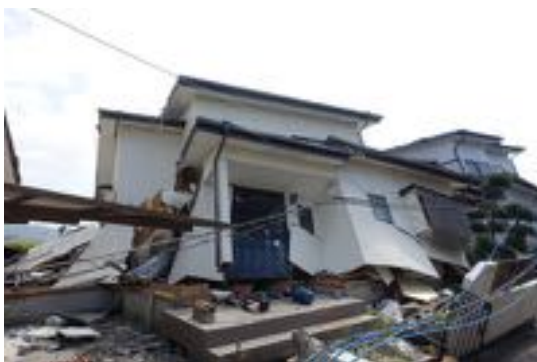
写真 2.11 倒壊した木造住宅
