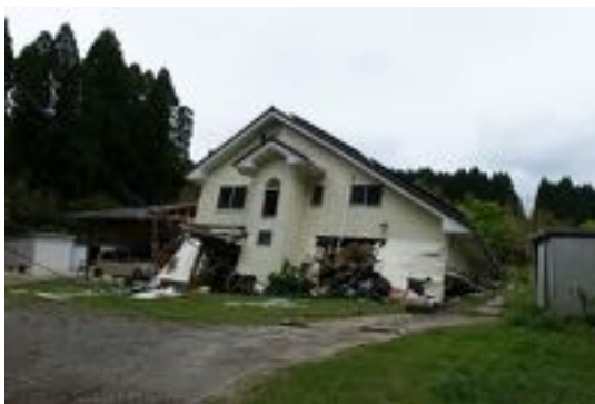
写真 4.15 倒壊した木造住宅（金物あり）
