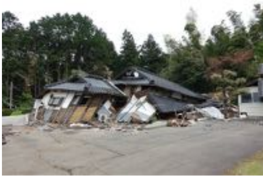
写真 3.17 倒壊した木造住宅
