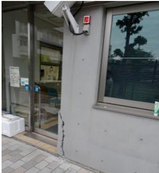
写真 3.1.16-3 外壁端部のひび割れ
