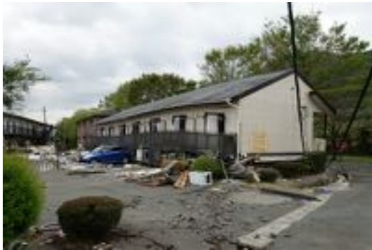
写真 4.23 倒壊したアパート②
