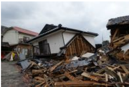
写真 4.13 倒壊した木造住宅
