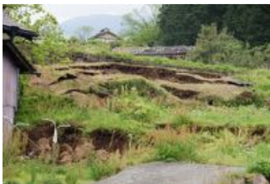
写真 3.14 地盤に生じた亀裂
