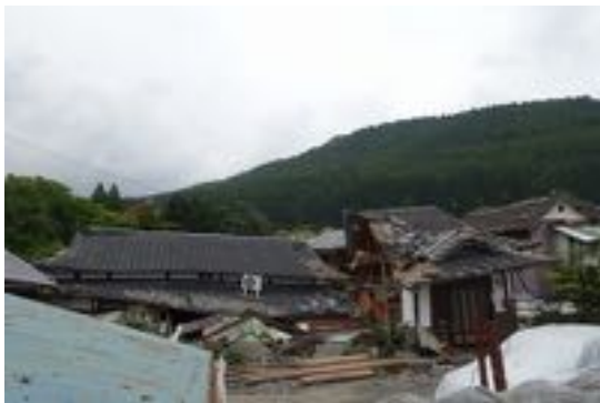
写真 3.5 分離した木造住宅
