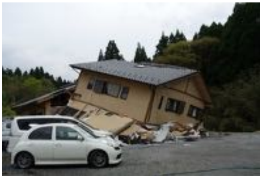
写真 4.11 倒壊した木造住宅
