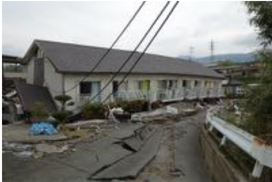
写真 4.29 倒壊したアパート③
