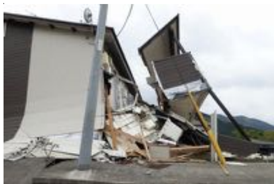
写真 4.32 鉄骨階段と木造部分の分離
