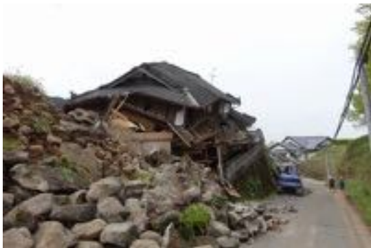
写真 3.19 倒壊した木造住宅
