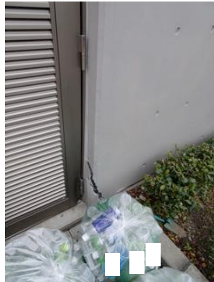
写真 3.1.16-3 外壁端部のひび割れ
