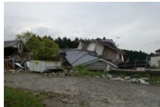
写真 4.14 倒壊した木造住宅
