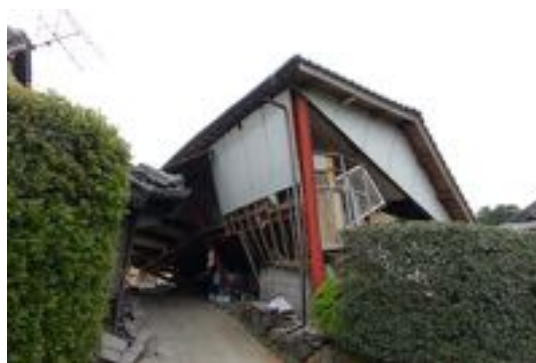
写真 3.26 倒壊した倉庫
