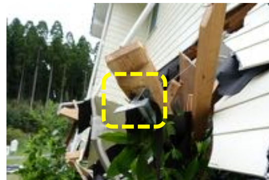
写真 4.16 写真 4.15 の住宅の柱頭部 （柱脚柱頭は金物あり）
