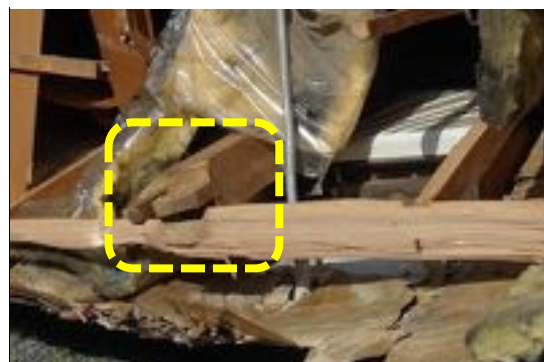
写真 2.20 写真 2.19 の住宅の柱頭部 (柱脚柱頭金物確認できず)
