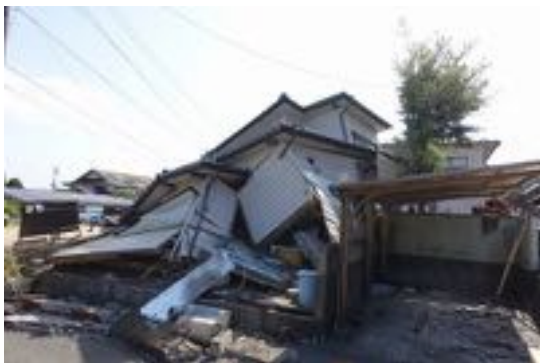
写真 2.15 倒壊した木造住宅
