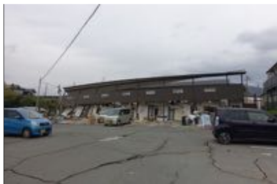
写真 4.34 敷地のひび割れ
