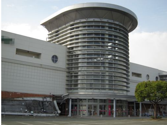
写真4.2.2.11 上部から内装材が脱落した吹き抜け 写真4.2.2.12 軒天井の脱落、ガラスの破損
