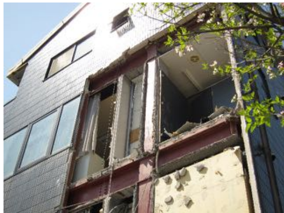
写真4.2.2.13 乾式工法による外壁材の損傷・傾斜 写真4.2.2.14 乾式工法による外壁材の脱落
