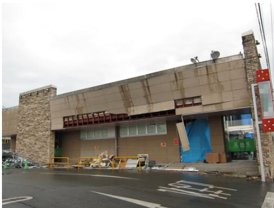
写真4.2.2.13 乾式工法による外壁材の損傷・傾斜 写真4.2.2.14 乾式工法による外壁材の脱落
