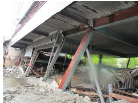
写真4.2.1.30 1層の層崩壊
