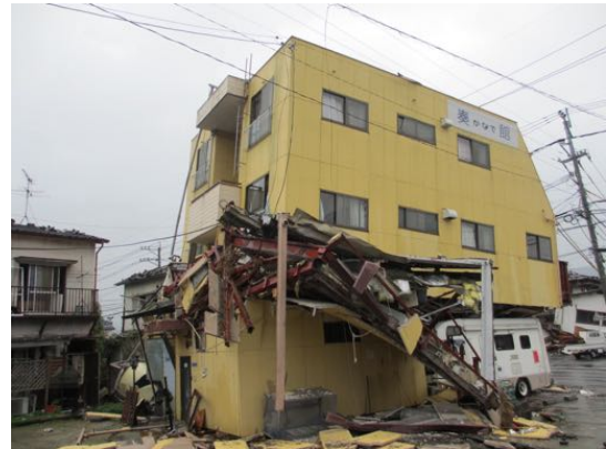
写真4.2.1.19 建築物の裏側からの外観
