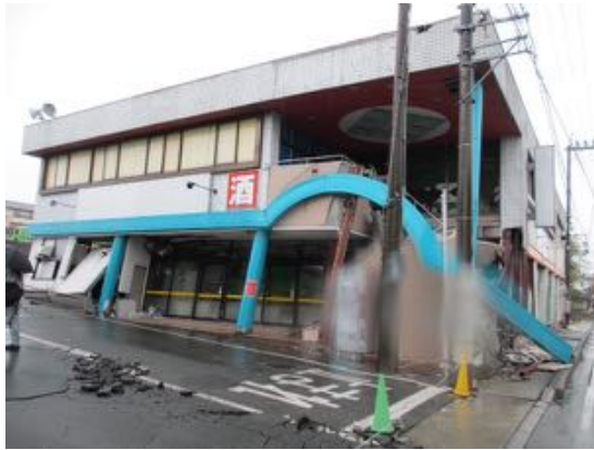
写真4.2.1.24 建築物外観（西面）
