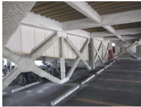
写真4.2.1.2 建築物内のブレースの様子
