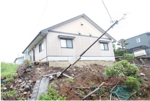
写真 4.25 軽微・無被害に見える建築物。擁壁は崩落、基礎に損傷なし(写真4.23より南の建築物)。
