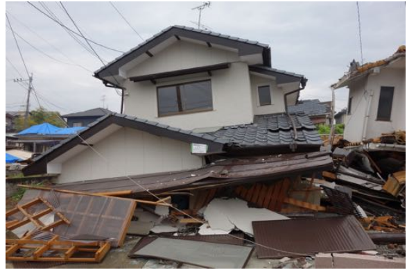
写真 4.26 倒壊した建築物
