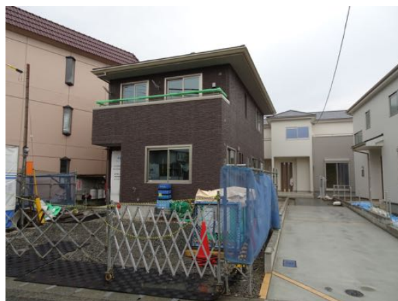
写真 5.17 被害の見られない新築中の 2 階建て木造住宅
