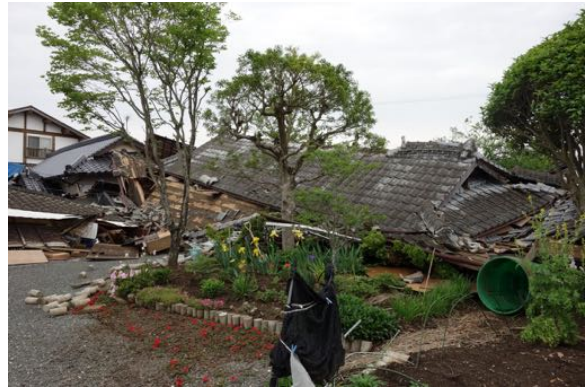
写真 4.13 倒壊した建築物。県道 28 号南側は古く見える建築物が多数倒壊
