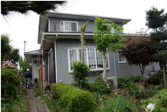
写真 4.14 造成宅地に立地する軽微・無被害と思われる建築物
