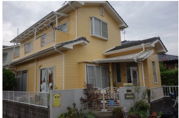
写真 4.6 軽微・無被害に見える建築物
