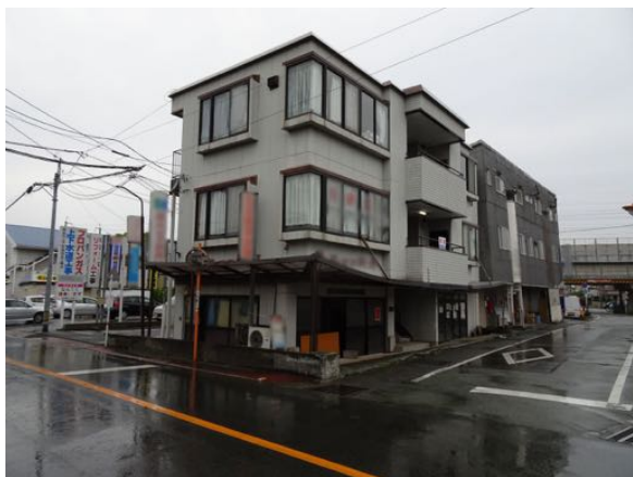
写真 5.14 地盤の液状化により沈下・傾斜したと思われる 3 階建て店舗併用住宅
