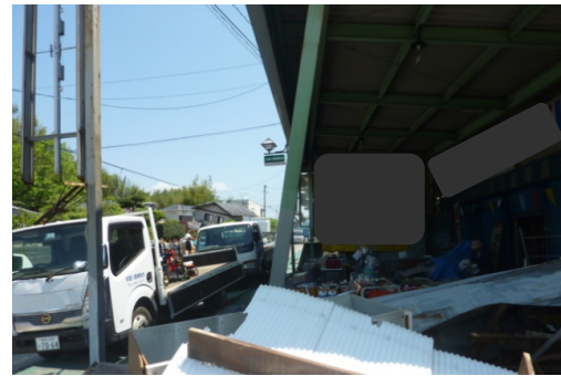
写真 5.14.2 柱の傾斜
