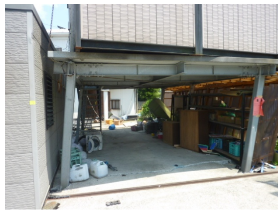
写真 5.16.2 柱の傾斜
