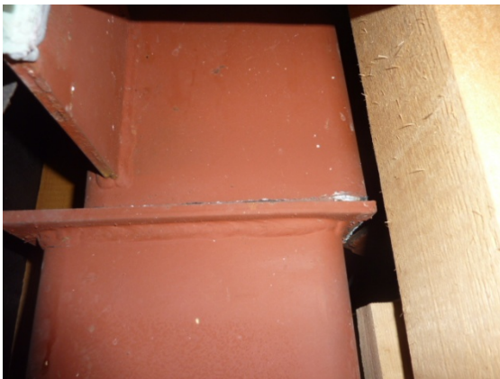
写真 5.9.3 (左) パネルとダイアフラム間の溶接部の破断
