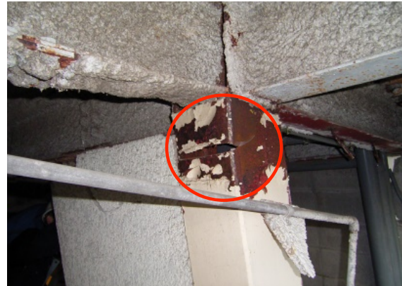
写真 5.12.2 柱の破断
