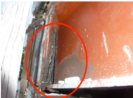
写真 5.12.3 梁端破断
