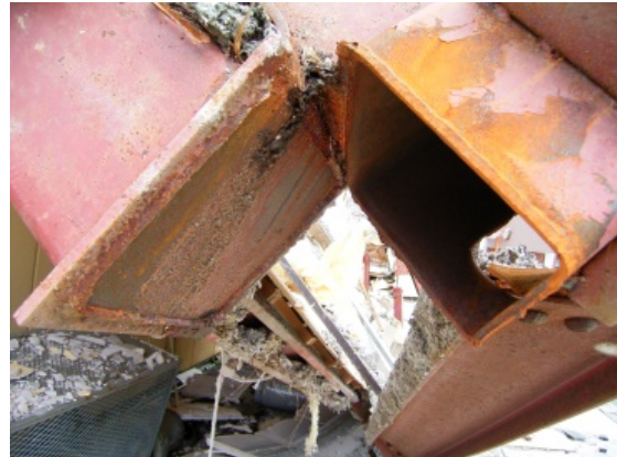
写真 5.1.2 (左) 写真 5.1.3 (右) パネルーダイアフラム間の溶接部の破断
