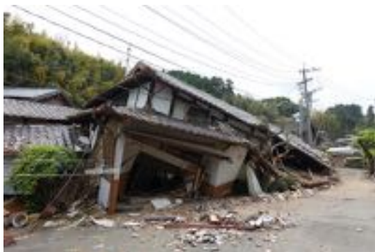
写真 3.15 倒壊した木造住宅
