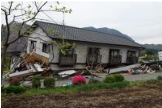
写真 4.5 倒壊した木造アパート
