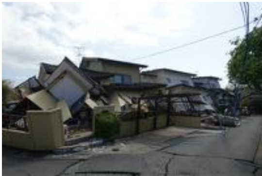
写真 2.21 倒壊した木造住宅
