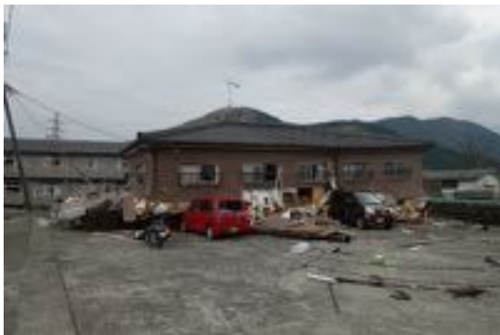
写真 4.3 倒壊した木造アパート
