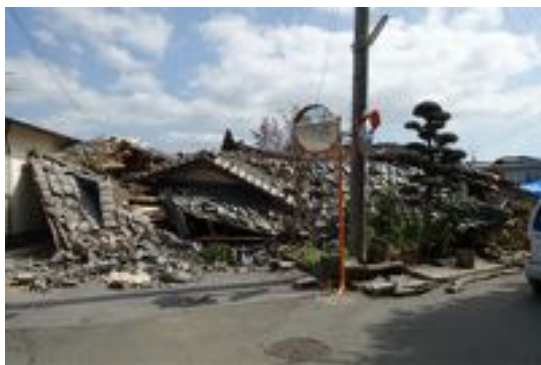
写真 2.1 倒壊した木造住宅
