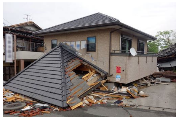
写真 4.29 建築年代が新しいと思われる倒壊建築物
