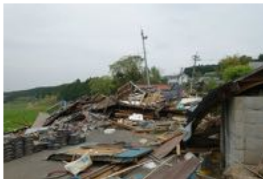
写真 3.16 倒壊した木造住宅
