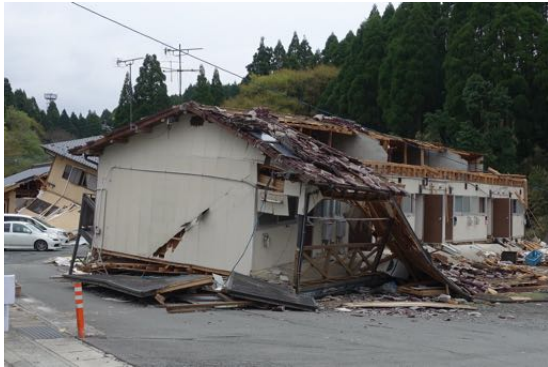
写真 4.1 倒壊した木造アパート
