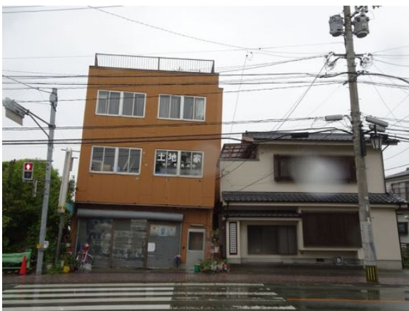
写真 5.7 地盤の液状化により沈下・傾斜したと思われる 3 階建て商用建築物
