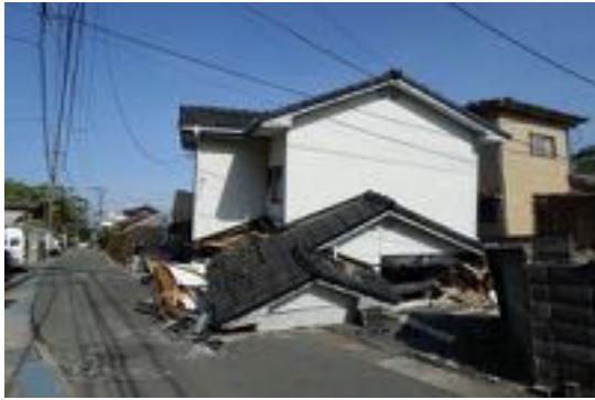
写真 2.13 倒壊した木造住宅
