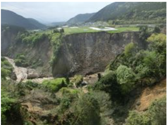
写真 5.3.7 黒川西岸の土砂崩落
