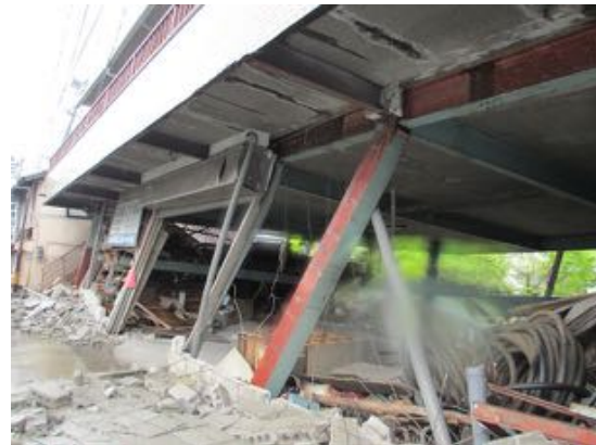
写真4.2.1.30 1層の層崩壊
