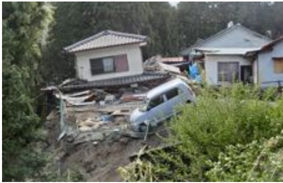
写真 5.3.4 国道 325 号沿いの倒壊家屋
