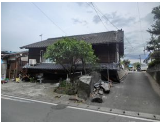
写真 5.7.9 木山地区の倒壊家屋
