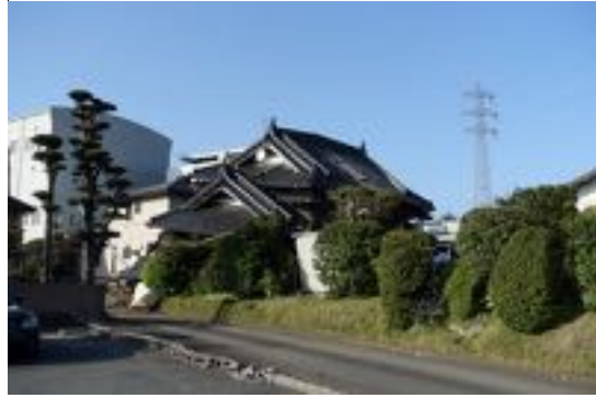
写真 2.30 大きく傾斜した木造住宅
