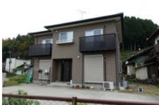
写真 3.22 外観上無被害の住宅
