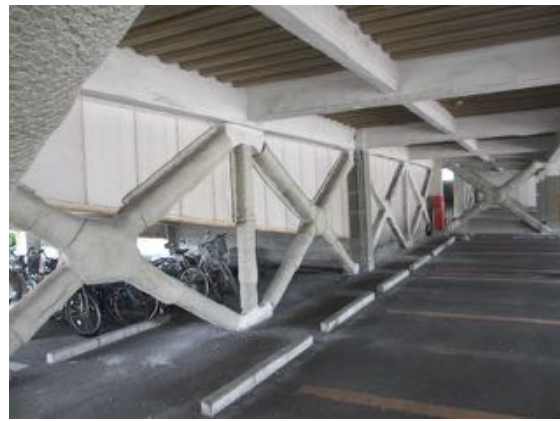
写真4.2.1.2 建築物内のブレースの様子
