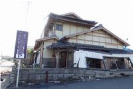
写真 2.31 部分破壊した木造住宅
