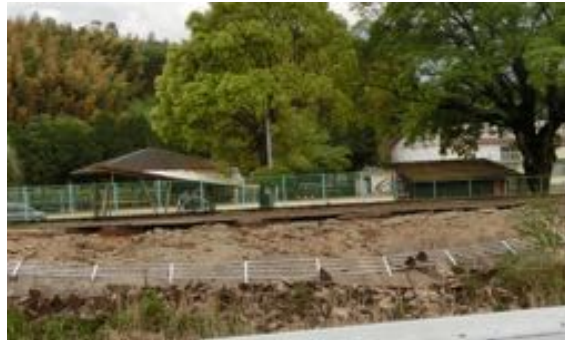
写真 5.6.7 崩壊した木山川の護岸
