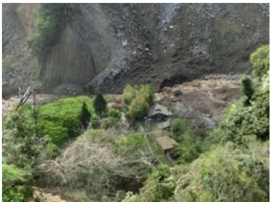
写真 5.3.8 土砂につぶされそうな建築物
