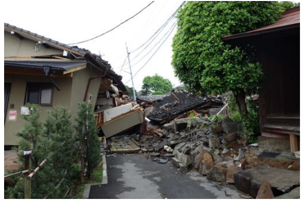
写真 4.31 倒壊した建築物。A 通りと同様に、県道 28 号南側は古く見える建築物が多数倒壊
