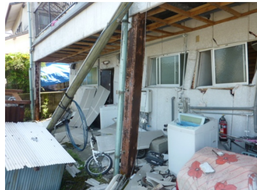
写真 5.13.2 柱の傾斜
