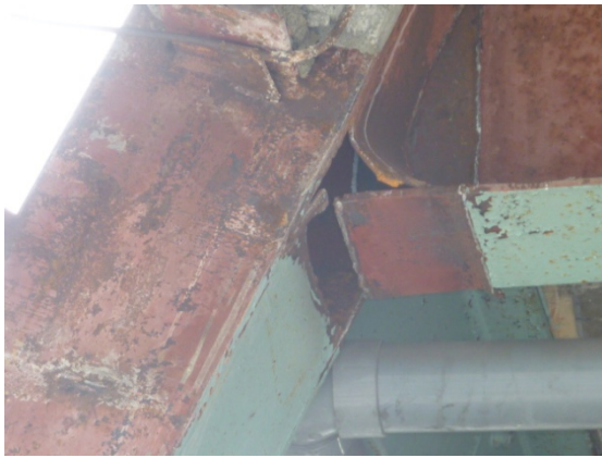
写真 5.2.2 梁端破断
