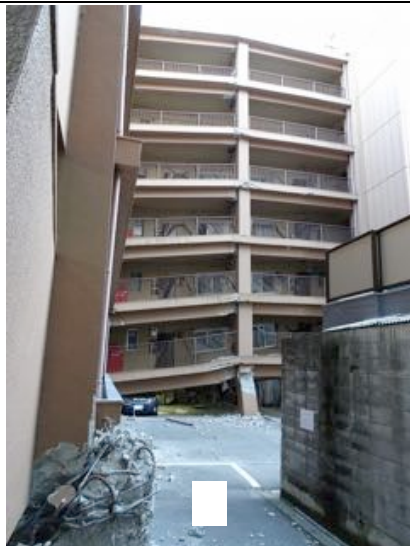
写真 3.1.10-3 東西軸住棟の北側
