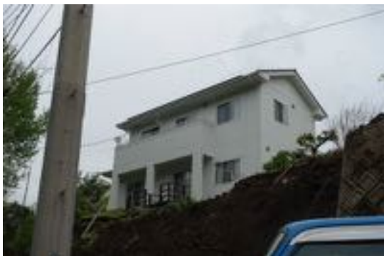
写真 3.21 外観上無被害の住宅
