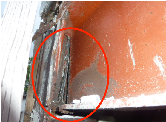
写真 5.12.3 梁端破断
