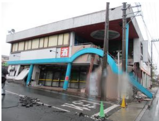
写真4.2.1.24 建築物外観（西面）
