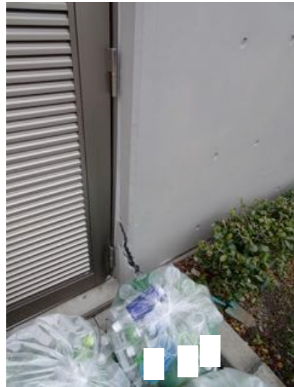
写真 3.1.16-3 外壁端部のひび割れ
