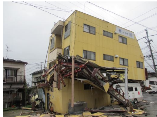
写真 4.2.1.19 建築物の裏側からの外観
