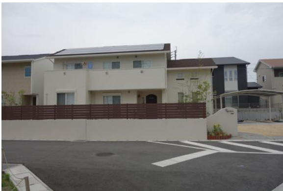
写真 4.9 新興住宅地と思われる建築物群。建築物は無被害に見える。道路舗装も健全
