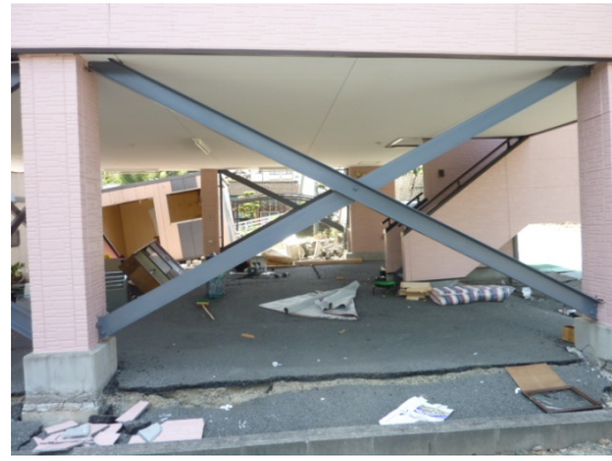
写真 5.15.2 ブレースの状況(ほぼ無損傷)
