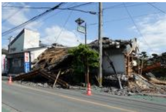
写真 2.3 倒壊した木造住宅
