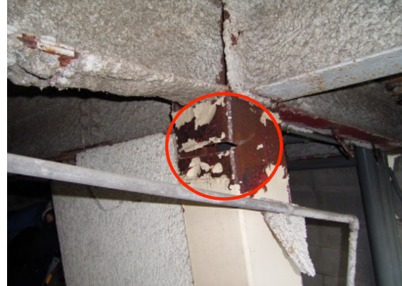
写真 5.12.2 柱の破断
