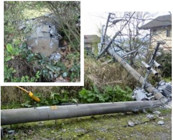
写真 5.2.6 エリア内の電柱の折損
