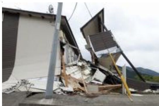
写真 4.32 鉄骨階段と木造部分の分離
