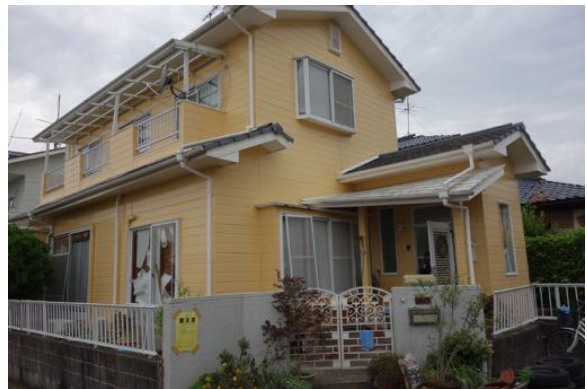
写真 4.6 軽微・無被害に見える建築物
