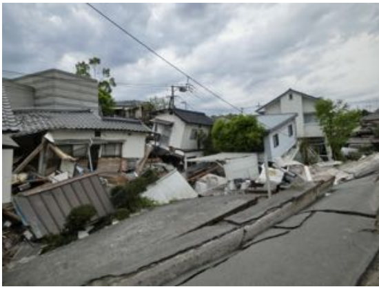
写真 5.7.1 路盤崩壊と倒壊家屋
