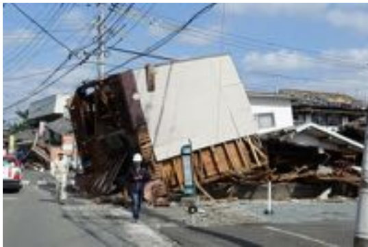
写真 2.5 倒壊した店舗併用木造住宅
