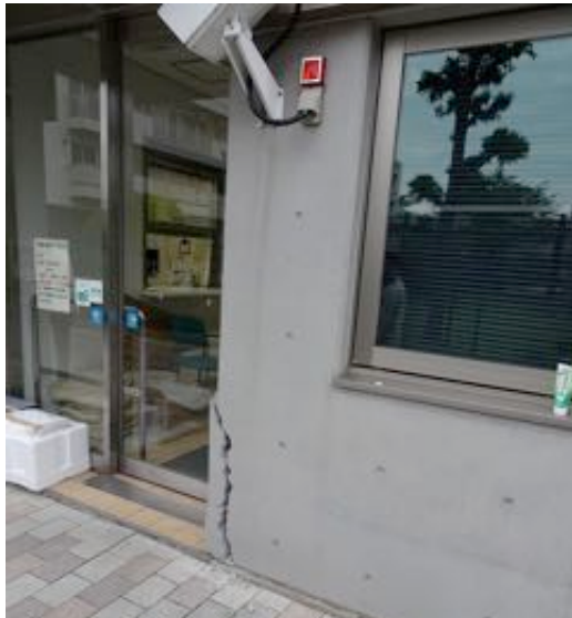
写真 3.1.16-3 外壁端部のひび割れ
