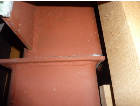
写真 5.9.3 (左) パネルとダイアフラム間の溶接部の破断
