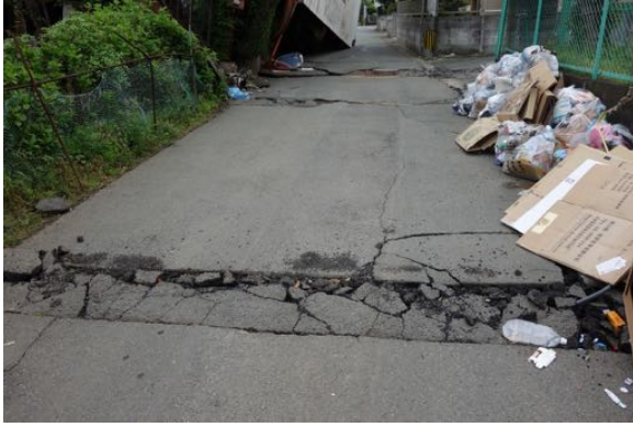
写真 4.1 A 通り・県道 28 号北側の道路の舗装の様子
