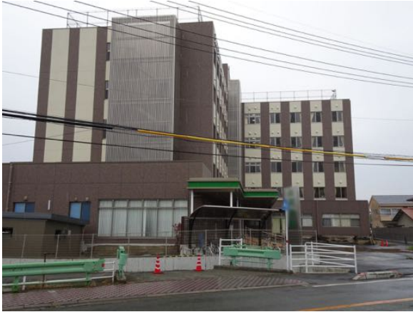
写真 5.9 地盤の液状化により周辺地盤が大きく沈下したと思われる病院
