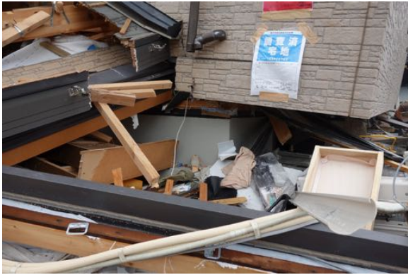
写真 4.30 写真 4.29 の建築物で辛うじて確認できる基礎。地盤変状はなく、基礎にも損傷は見当たらない。
