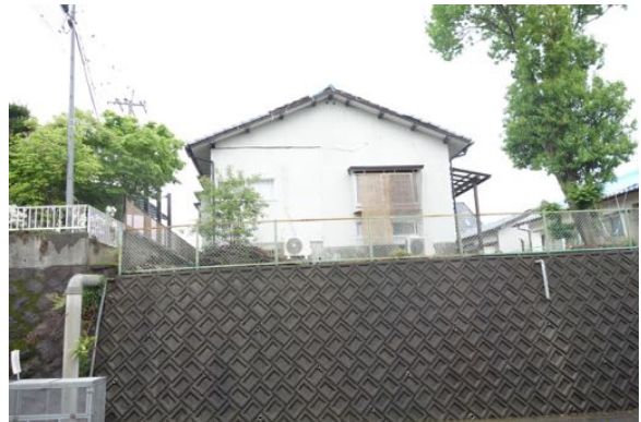
写真 4.22 軽微・無被害に見える建築物。擁壁にも損傷が見当たらない。
