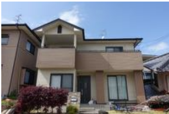
写真 2.25 外観上無被害の木造住宅
