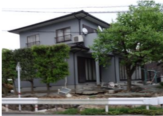
写真 5.7.8 最近の建築と思われる住宅で被害が小さい例
