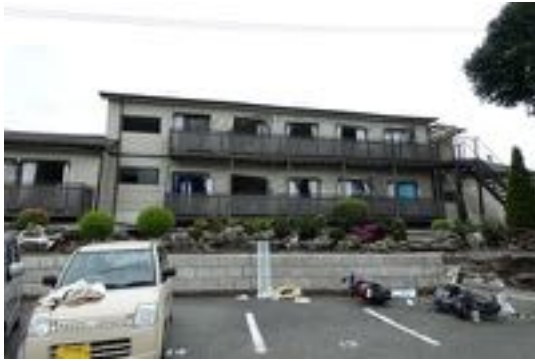
写真 4.9 大破した木造アパート
