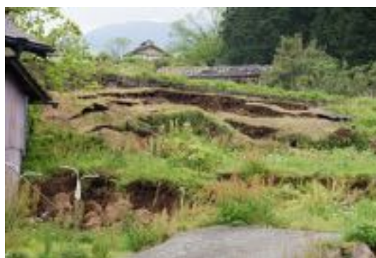
写真 3.14 地盤に生じた亀裂
