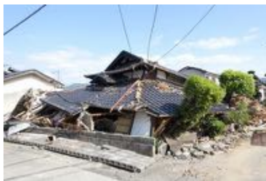
写真 2.2 倒壊した木造住宅
