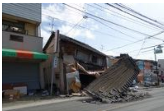
写真 2.4 倒壊した木造住宅
