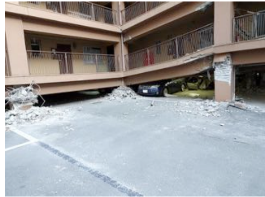
写真 3.1.10-2 L 字型平面形状の入り隅部
