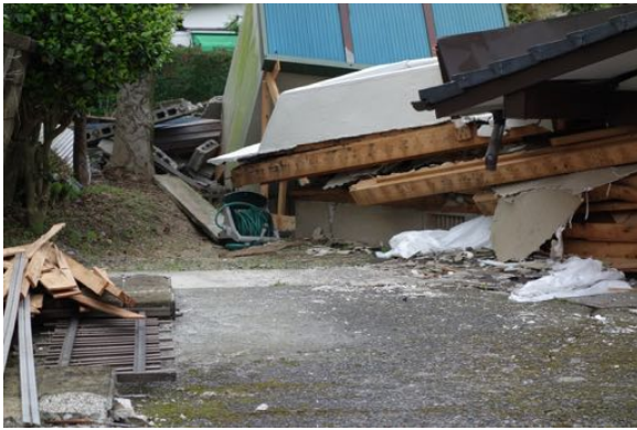
写真 4.3 写真 4.2 の基礎のひび割れを確認。地盤変状は確認できなかった。
