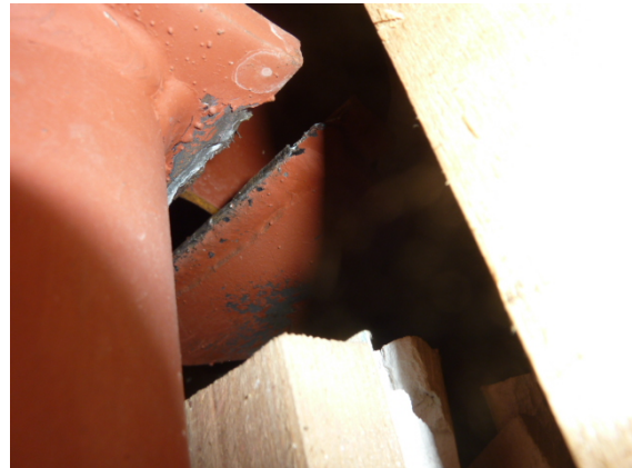
写真 5.9.2 梁端破断
