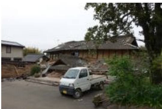
写真 3.25 倒壊した木造住宅
