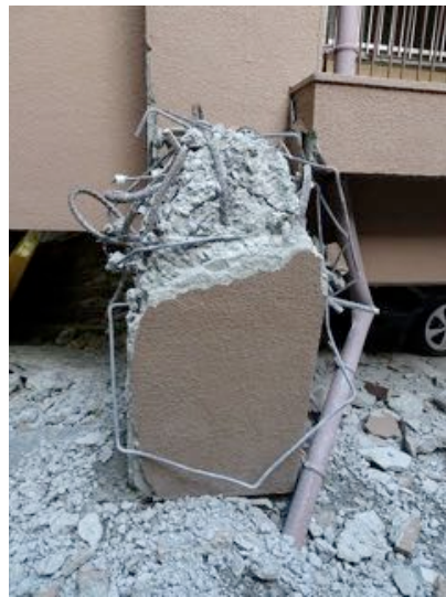
写真 3.1.10-4 南北軸住棟の西側柱
