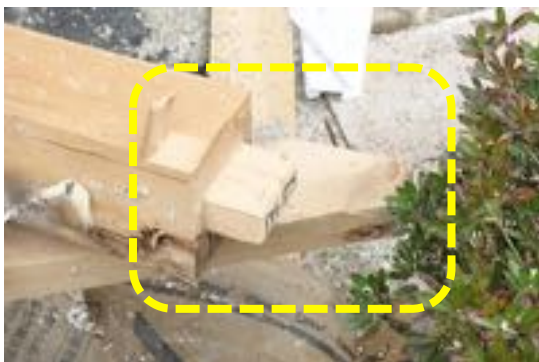
写真 4.25 柱頭部（釘打ちによる接合）
