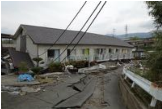
写真 4.29 倒壊したアパート③
