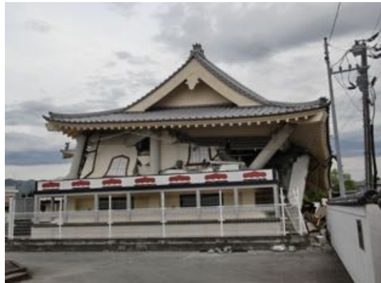
写真 5.7.12 大破した RC 造の社寺
