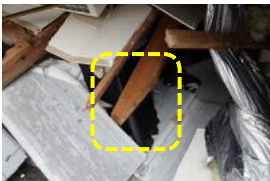
写真 4.33 柱頭、筋かい端部接合部 (釘打ちによる接合)
