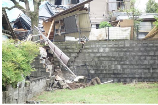
写真 4.37 写真 4.35 の南側にある擁壁。大きな亀裂が見える。
