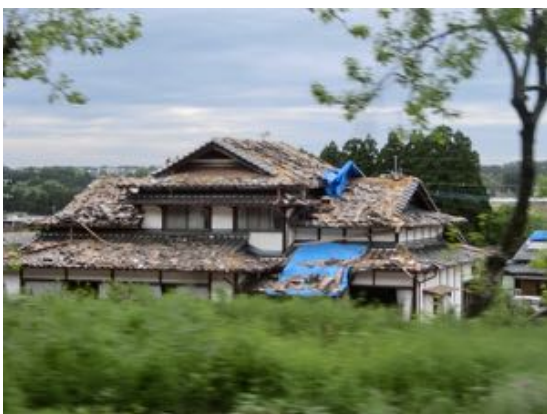
写真 5.5.1 屋根の被害が大きな入母屋
