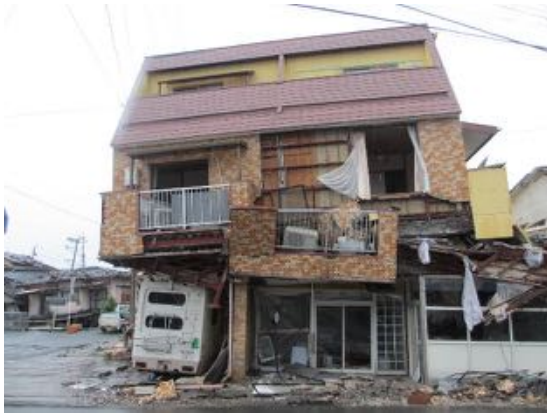
写真 4.2.1.18 建築物正面の外観
