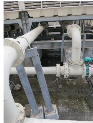
写真 4-19 配管置き基礎の移動
