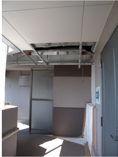
写真 5.8.4 エキスパンション部の変状①（天井被覆は撤去済み）
