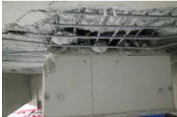
写真 5.3.3 鉛ダンパー取付け基部の被害（床スラブの破損）
