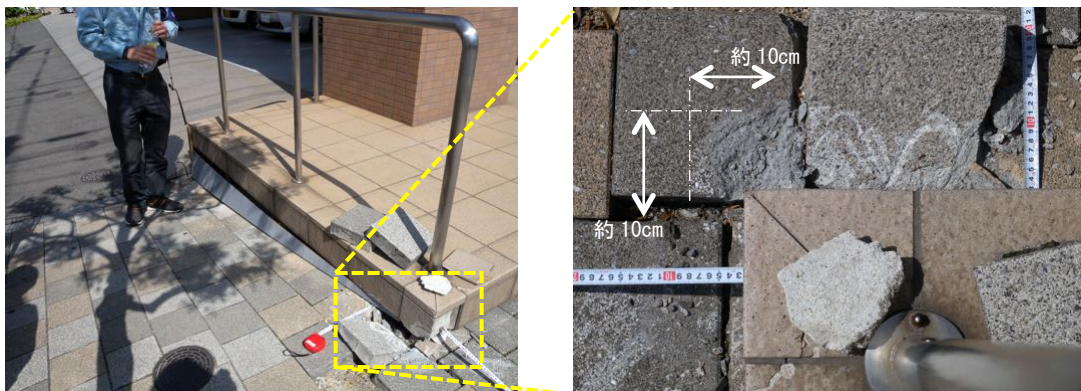
写真 5.9.5 犬走り部分の周囲との接触跡 (右図は左図囲み部分の拡大)
