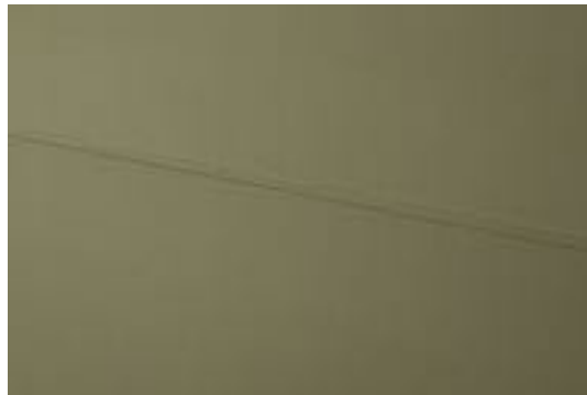
写真 5.2.3 階段室の内装クロスのずれに伴うしわ
