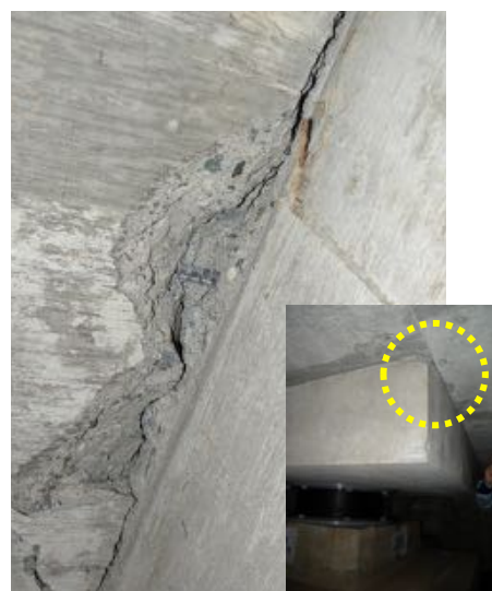
写真 5.7.6 外付け階段の被害と階段下に設置された積層ゴム支承の取り付け基部の損傷
