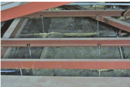
(g) ぶどう棚の溝形鋼に付けられた吊りボ ルト (d ホール上部)
