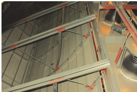
(f) 天井裏の状況
