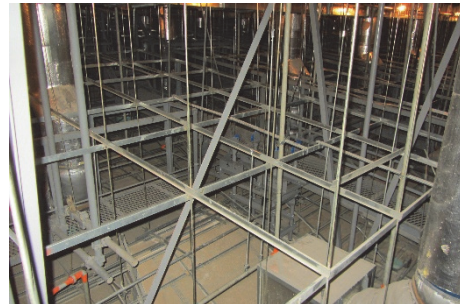
(d) 天井裏 多数の水平補剛材
