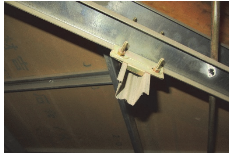
(d) 野縁ハット鋼とねじ留めクリップ
