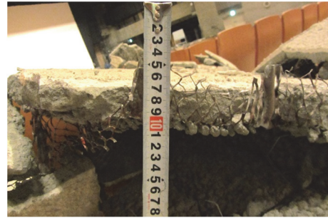
(d) ラスモルタル天井 (モルタル厚さ約 4cm)
