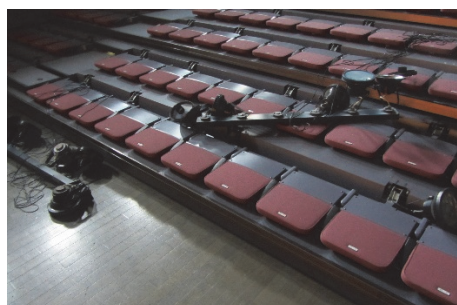
(c) 落下した照明
