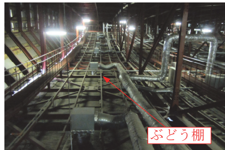
(f) 天井裏 (吊り元はぶどう棚、d ホール上 部)
