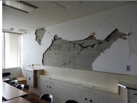
写真5 大きく損傷したベランダ側の非耐力壁
