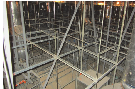
(d) 天井裏 多数の水平補剛材
