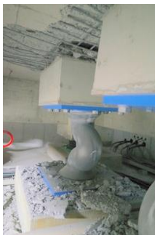
写真1 鉛ダンパー取付け基部の破損とスラブの被害
