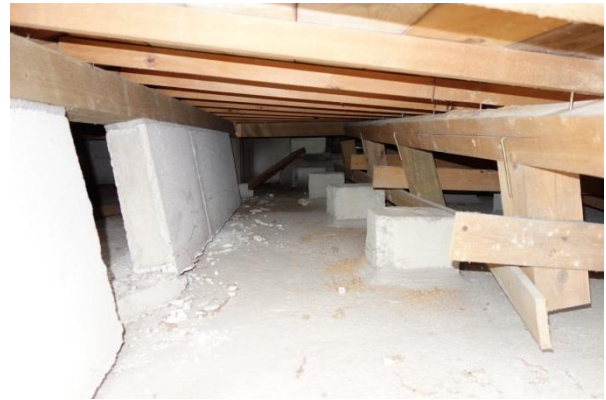
写真2 地盤変状が認められ、基礎に損傷が著しい事例1
