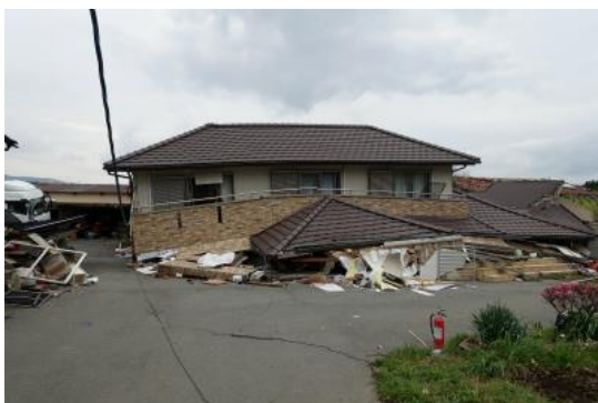
写真16 倒壊した木造住宅
