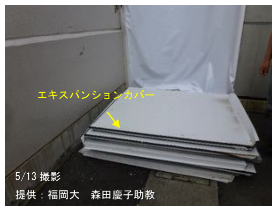
写真 5. 10. 3 エキスパンション部の破損と取り外されたカバー
