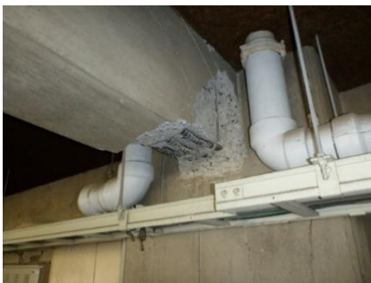
写真1 大きく損傷した柱頭部
