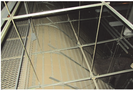
(c) 天井裏 (勾配天井と水平補剛材)
