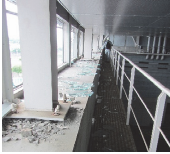
(i) 屋根支承部及びガラス (d ホール)
