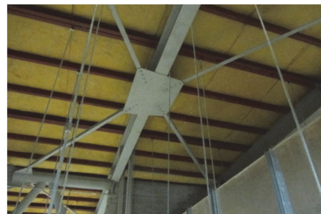
(l) 吊り元は屋根の母屋
