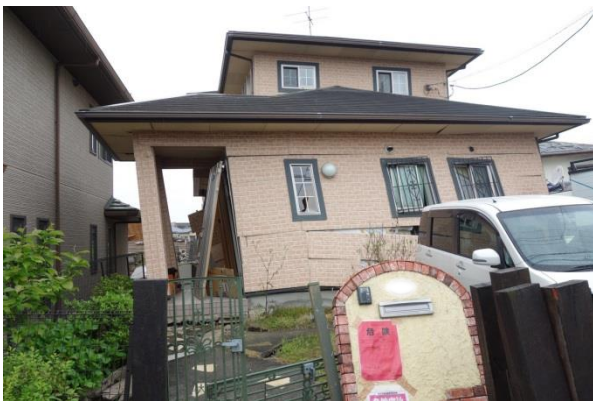
写真4 地盤変状が認められ、基礎の損傷が軽微・無損傷の事例
