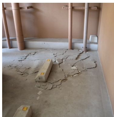
写真 5.9.3 免震層上面にあたる床スラブの損傷
