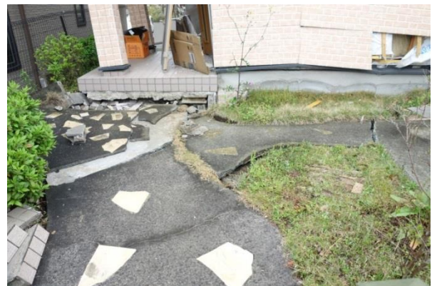
写真4 地盤変状が認められ、基礎の損傷が軽微・無損傷の事例
