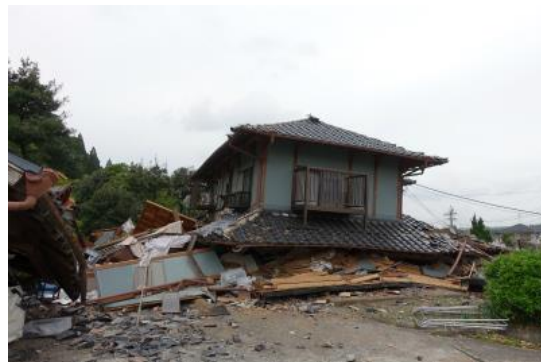
写真 9 倒壊した木造住宅
