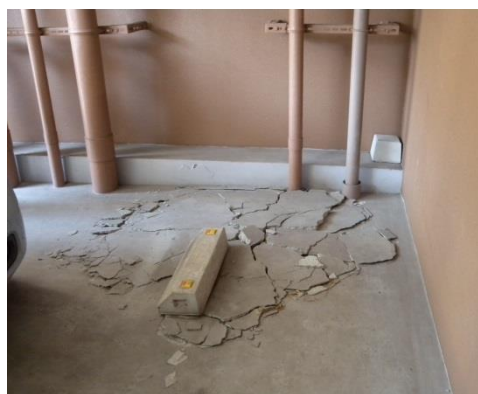
写真1 鉛ダンパー取付け基部の破損とスラブの被害
