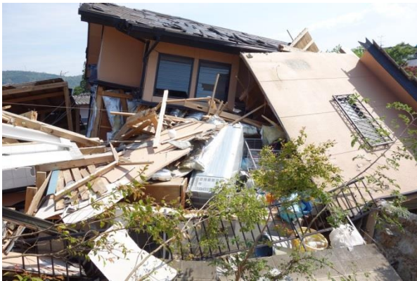
写真3 地盤変状が認められ、基礎に損傷が著しい事例2
