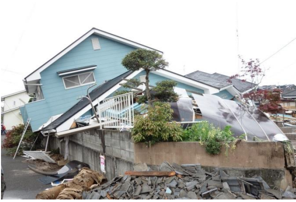
写真1 建築物が倒壊したことにより基礎もしくは敷地地盤全体の状況確認が困難な事例
