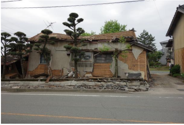
写真5 地盤変状が認められないが、基礎に損傷が認められる事例
