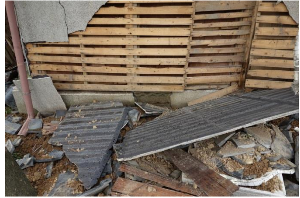
写真5 地盤変状が認められないが、基礎に損傷が認められる事例
