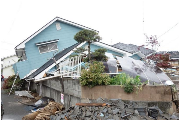
写真 3.6-2 建築物の倒壊により基礎もしくは敷地地盤全体の状況確認が困難な事例（2例）
