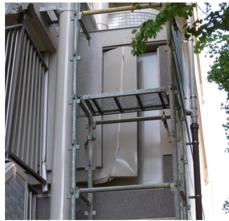
写真 3.7-9 同 変状② (建築物H (W棟) : 左は渡り廊下手すり壁の変形、右はカバーの変形)
