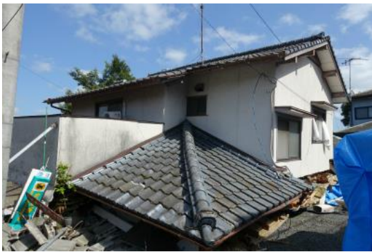
写真 3.3-2 倒壊した木造住宅
