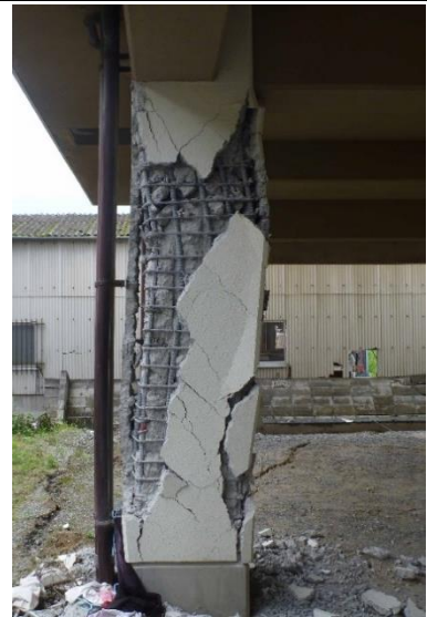
写真 3.5-3 付着割裂破壊した柱
