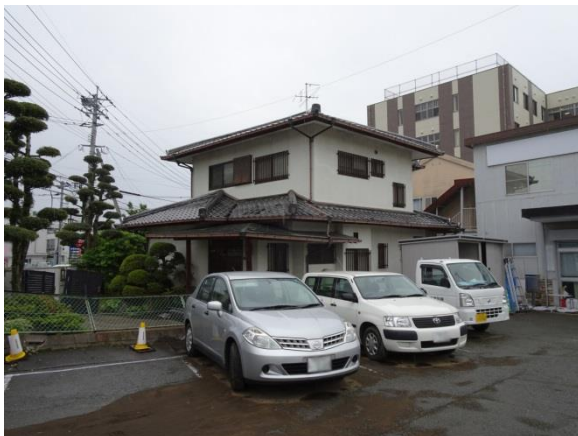
写真 3.6-6 地盤の液状化により沈下・傾斜したと思われる 2 階建て木造住宅と 1 階玄関部分の沈下状況
