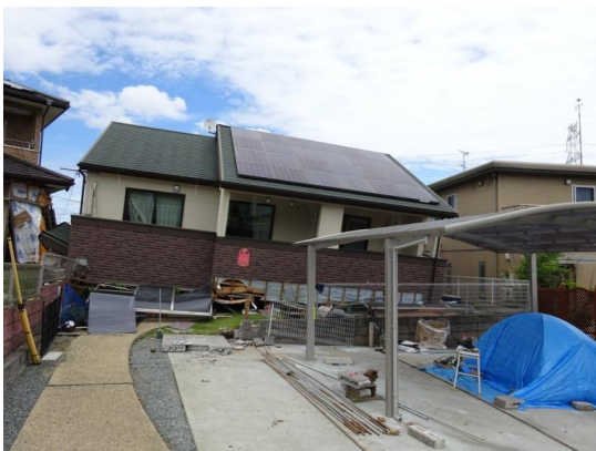
写真 3.3-4 倒壊した木造住宅
