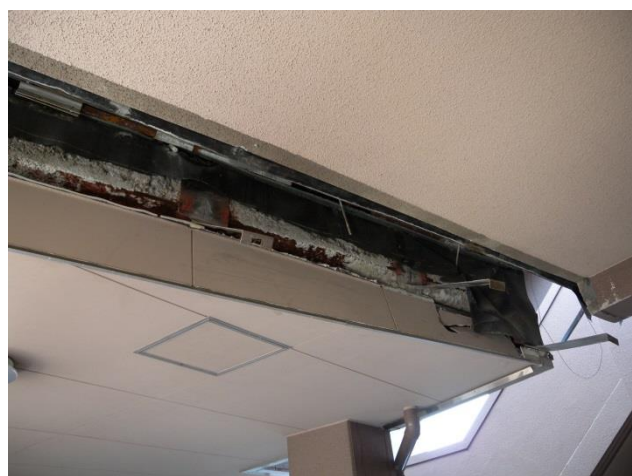
写真 3.7-8 エキスパンション部の変状 (建築物G : 破損した天井被覆を撤去済み)
