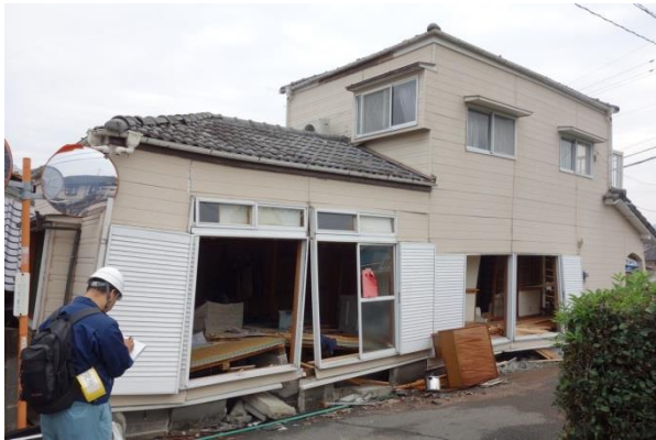
写真 3.6-3 地盤変状が認められ、基礎に損傷が著しい事例 1
