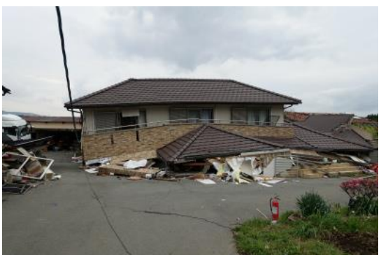
写真 3.3-16 倒壊した木造住宅
