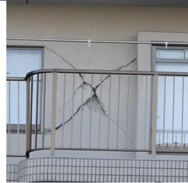
写真 3.5-3 付着割裂破壊した柱
