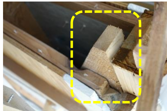
写真 3.3-13 筋かい端部 (釘打ちによる接合)
