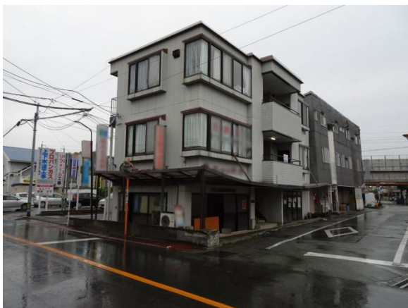
写真 3.6-9 地盤の液状化により沈下・傾斜したと思われる 3 階建て店舗併用住宅
