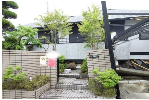
写真 3.6-2 建築物の倒壊により基礎もしくは敷地地盤全体の状況確認が困難な事例（2例）
