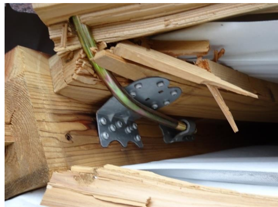
写真 3.3-5 写真 3.3-4 の建物の写真筋かい端部、柱脚接合部
