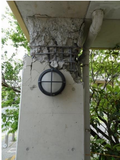
写真 3.5-1 主筋が座屈・破断した柱頭部
