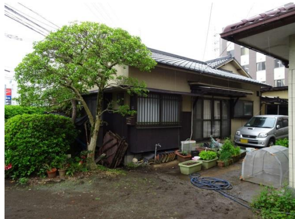
写真 3.6-6 地盤の液状化により沈下・傾斜したと思われる 2 階建て木造住宅と 1 階玄関部分の沈下状況
