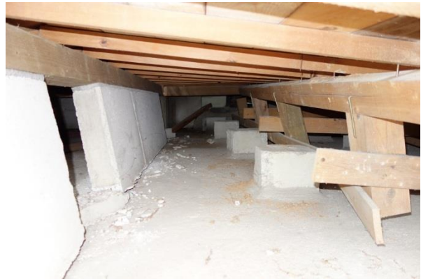
写真 3.6-3 地盤変状が認められ、基礎に損傷が著しい事例 1
