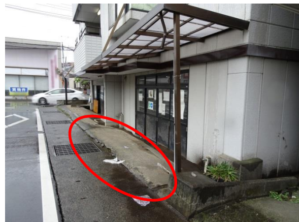
写真 3.6-9 地盤の液状化により沈下・傾斜したと思われる 3 階建て店舗併用住宅
