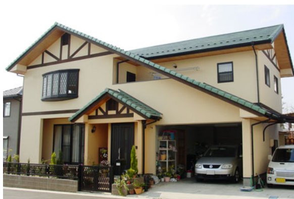
湿式構法(モルタル塗りの上に吹付け塗装仕上げした事例)
