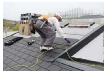
屋根の断熱化工事
