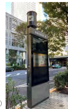
5Gアンテナ搭載のスマートポール（国総研撮影）
