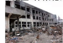
地震誘発火災被害例
