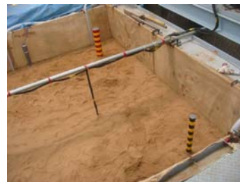
浮き上がり埋設物
