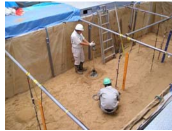
動的平板載荷試験の状況
