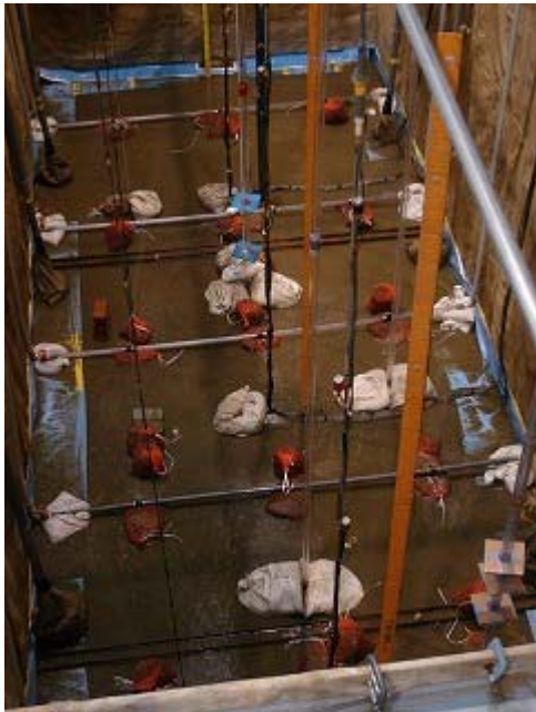
写真4 逆止弁配管・バルブ設定状況
