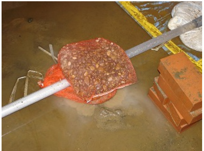
写真5 逆止弁周り養生状況
