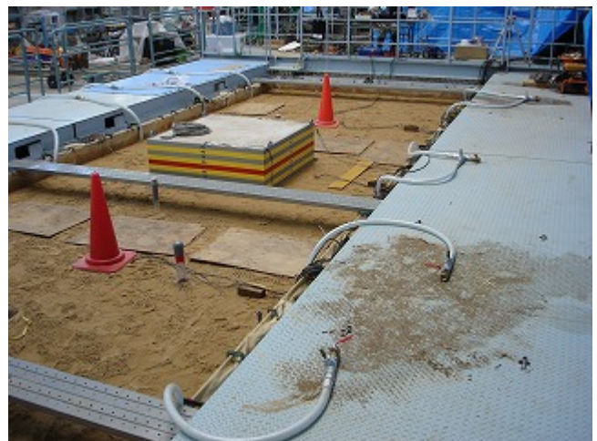
写真13 MB水エア抜き縦配管
